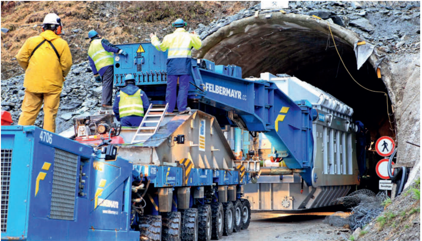
Der insgesamt 220 Tonnen schwere Trafo auf dem Weg zu dem im Berginneren gelegenen Krafthaus des ältesten Großkraftwerks Österreichs, dem 1955 in Betrieb gegangenen Kraftwerk Kaprun
