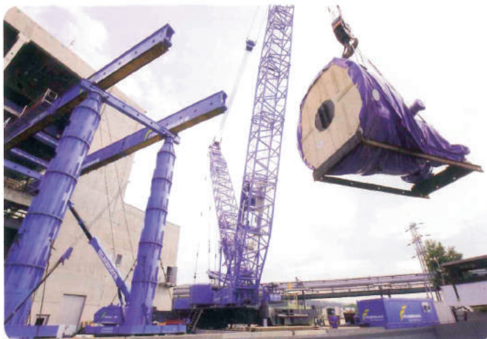
Kombinierte Hebetechnik: Der LR 1750 setzt das Anlagenteil auf ein Verschiebegerüst.
