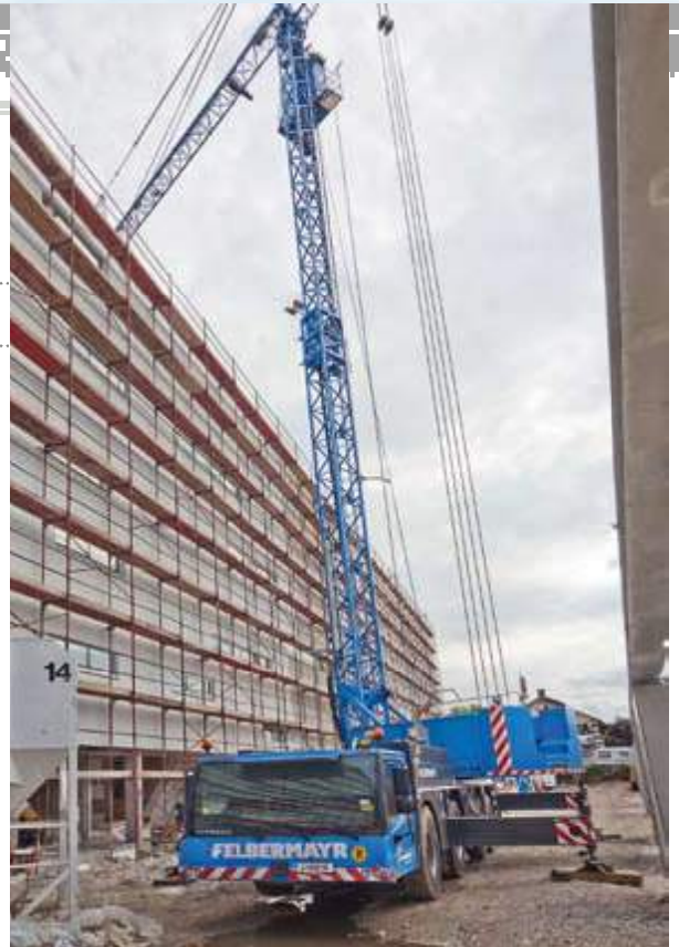
Ein MK88-Mobilbaukran hilft bei der Errichtung des Wohnparks Kalvarienberg.
