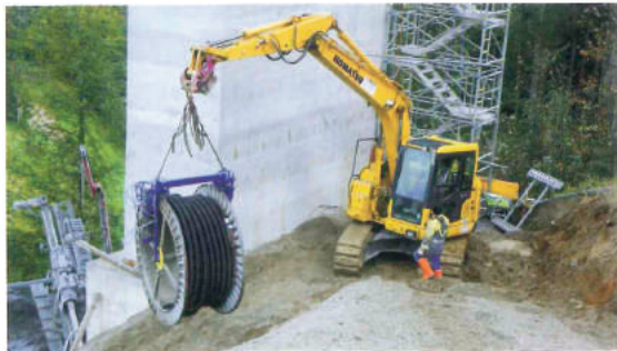
Abb. 2: Transport eines aufgetrommelten Ankers in steilem Gelände
