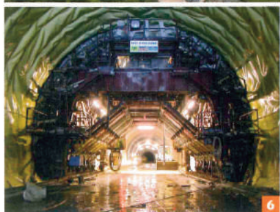
5 Auch mehrere Abschnitte der Tauernbahn Nordrampe wurden in den letzten Jahren zweigleisig ausgebaut. Es entstanden unter anderem der Birgl- und der Klammtunnel 6 Heute kommen im Tunnelbau moderne Schalwagen zum Einsatz 7 Beim Südportal des Kaponig Tunnels kreuzte die alte Trasse der Tauernbahn die neue in einem 90°-Winkel 8 Die Falkensteinbrücke ist mit einer Länge von 396 m die längste Stahlbetonbogenbrücke der Tauernbahn
