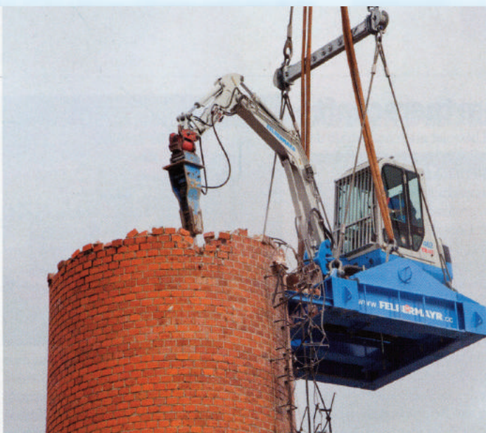
Abbruch eines 52 m hohen Schornsteins mittels Mobilkran und Minibagger
