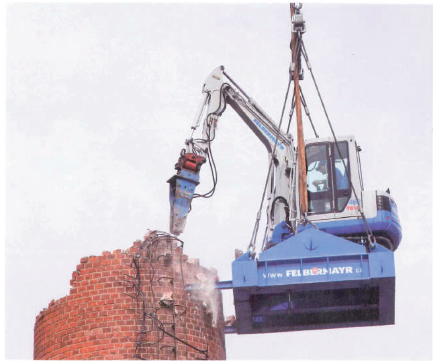
Ungewöhnlicher Einsatzort: Auf einem adaptierten Hebeplateau sorgte diese Takeuchi TB 145 für den Abbruch des Schornsteins der Firma VFI.
