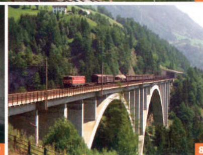
5 Auch mehrere Abschnitte der Tauernbahn Nordrampe wurden in den letzten Jahren zweigleisig ausgebaut. Es entstanden unter anderem der Birgl- und der Klammtunnel 6 Heute kommen im Tunnelbau moderne Schalwagen zum Einsatz 7 Beim Südportal des Kaponig Tunnels kreuzte die alte Trasse der Tauernbahn die neue in einem 90°-Winkel 8 Die Falkensteinbrücke ist mit einer Länge von 396 m die längste Stahlbetonbogenbrücke der Tauernbahn
