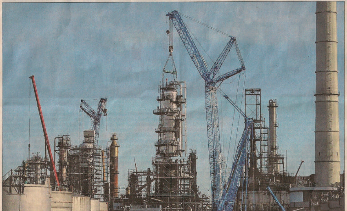
MiRO: Der 23 Meter hohe Kolonnenkopf hängt für den Austausch an einem 600 Tonnen schweren Raupenkran.
