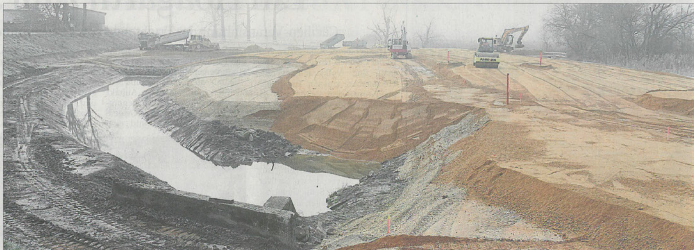
Die Erdbewegungen im Vorland beim Schöpfwerk 1 lassen die Dimensionen der Maßnahme erahnen. Dort wird der Deich Richtung Donau verlegt, um Platz für das neue Schöpfwerk zu schaffen. – Fotos: Roland Binder
