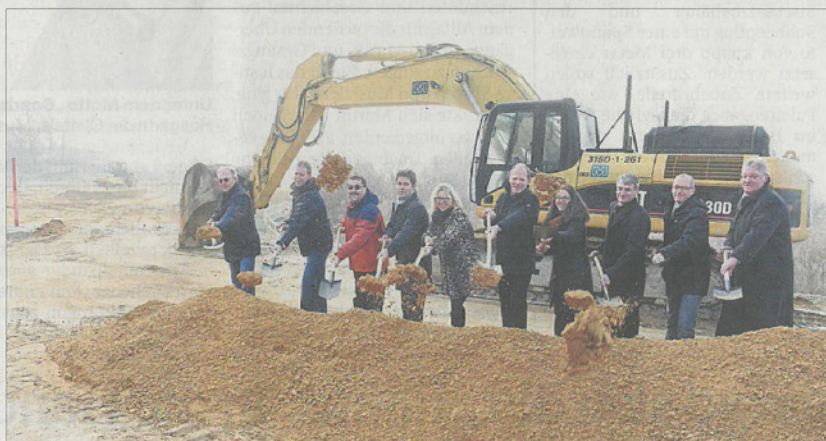
Spatenstich auf der Großbaustelle (v.l.): Johann Maidl (Fa. Meister), Hermann Waas (WWA), Vize-Landrat Peter Erl, Martin Popp (Regierung), 2. Bürgermeisterin Friederike Sandner, Wolf-Dieter Rogowsky (WWA), Heidi Bischoff (LRA), Herbert Baumgartner (RMD), Markus Schmautz (RMD) und Bürgermeister Jürgen Roith.
