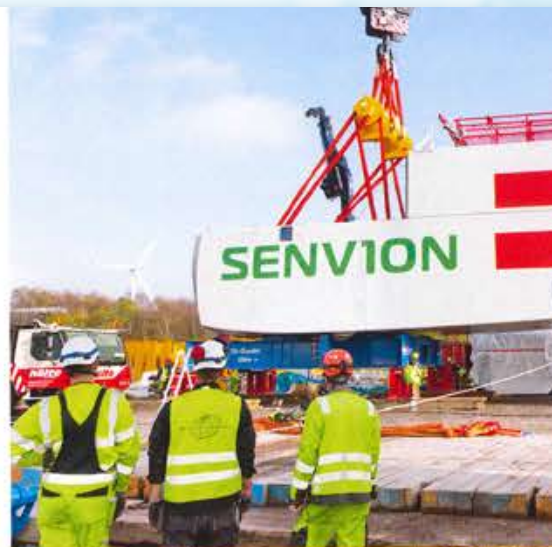
Passender Lastfall: Das Maschinenhaus der 6.2M152-Turbinen von Senvion legt sich brutto mit 220 t in die Rundschiene.
