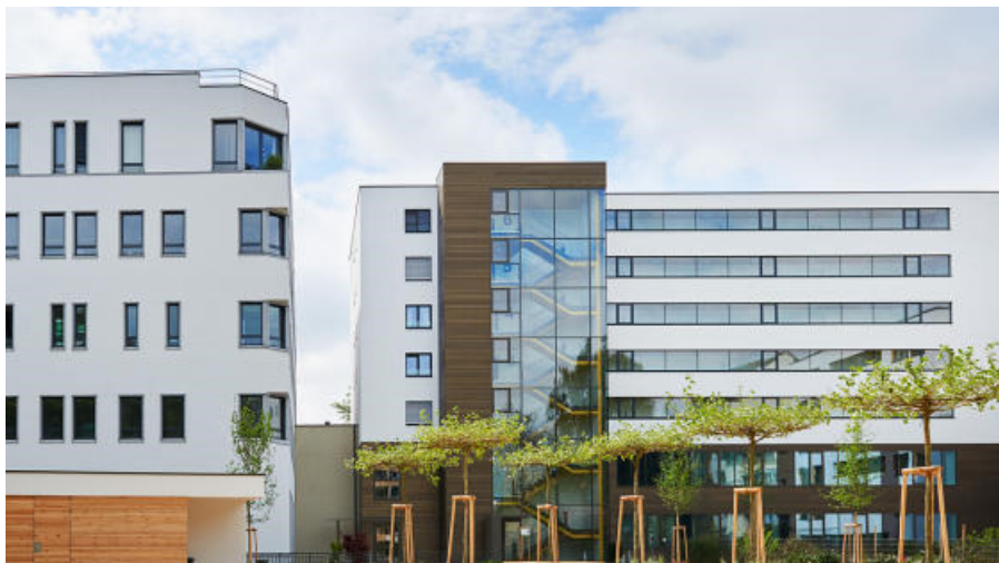
Das Gebäude in der Mitte ist der neue "Querriegel", der die Lücke zwischen Gruber- und Honauerstraße schließt. Bild: (OÖ. Vers.)
