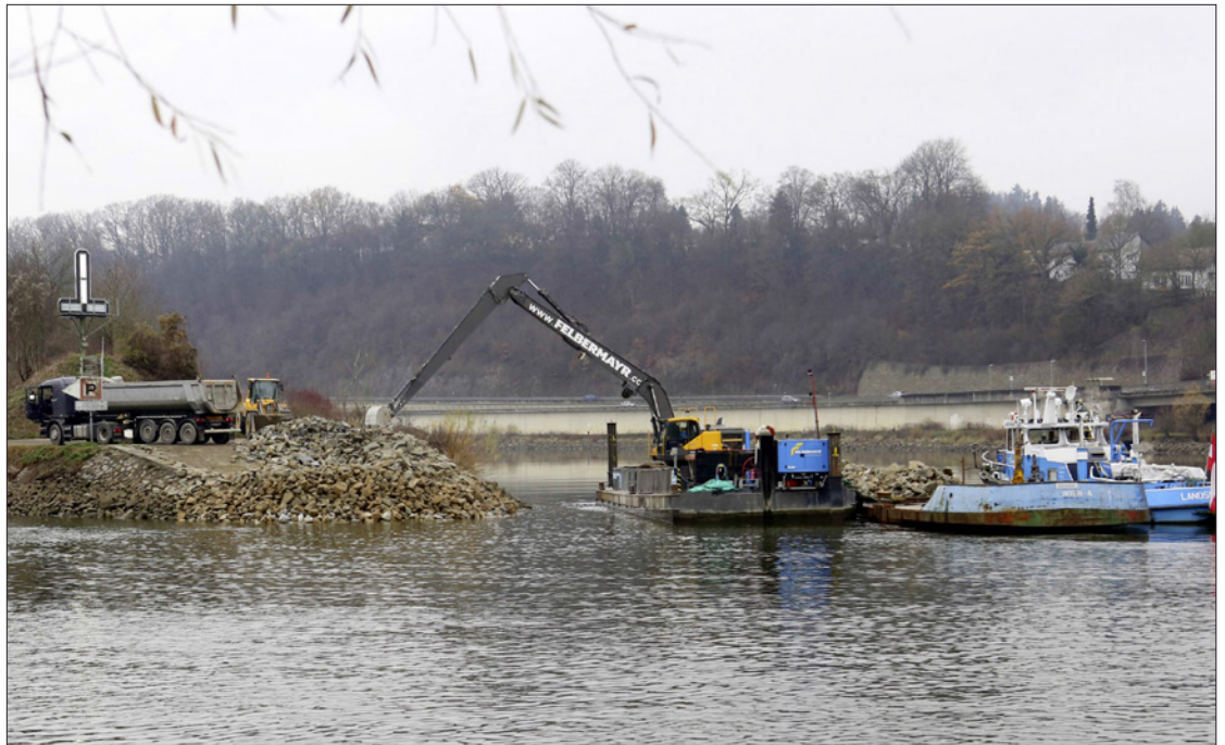
An der Landspitze der Racklau liefern Lastwagen die Granitblöcke aus Hauzenberg an. Ein Langarm-Bagger auf einem Ponton verlädt sie dann auf ein Schiff mit Steinschütte. Wenn das voll ist, schwimmen Schiff und Bagger donauabwärts zur Baustelle am Ort. – Foto: Jäger
