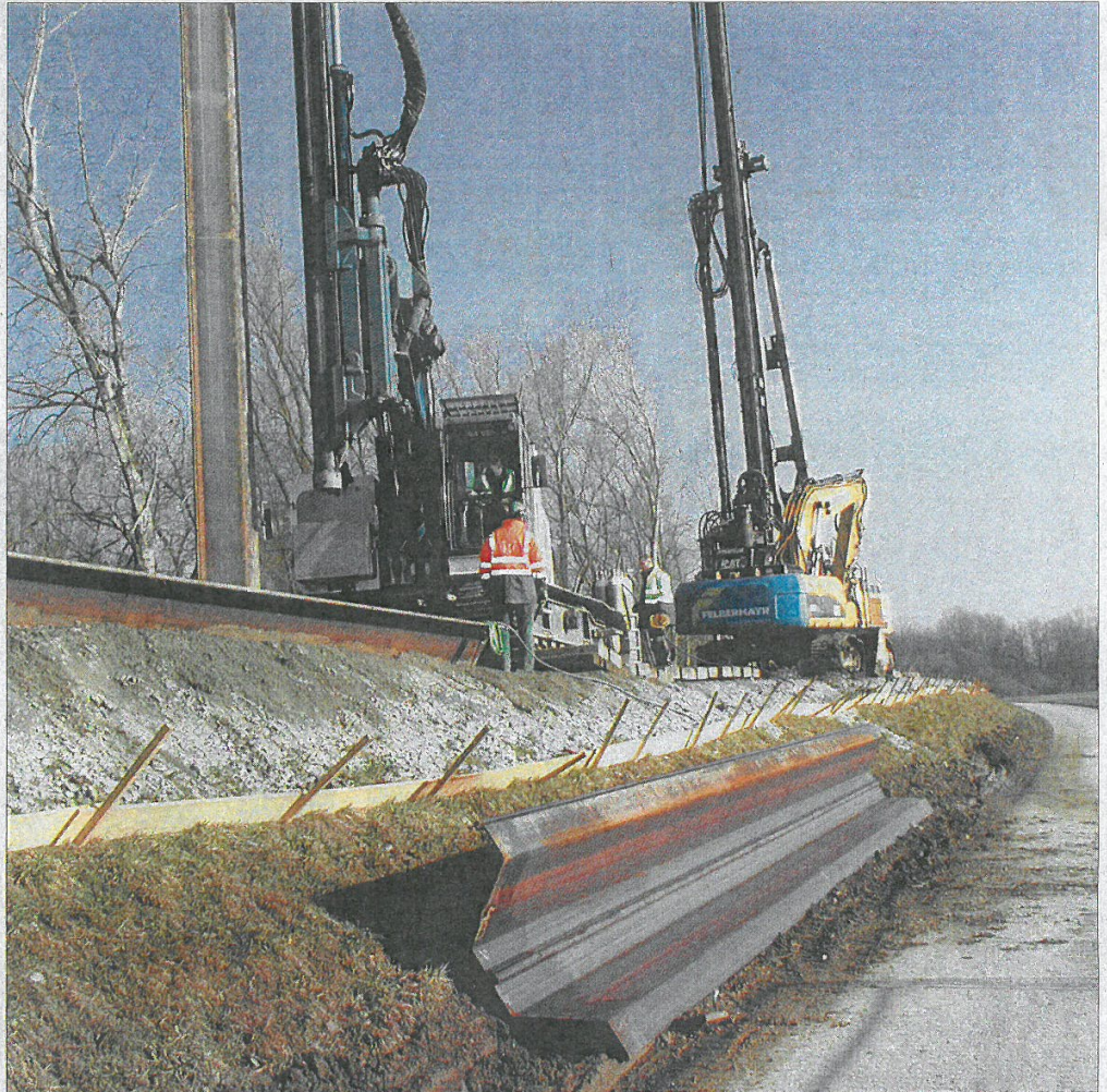
Mit Hochleistungsbohrern und Spundwandrammen ist die Firma Meister GmbH derzeit damit beschäftigt, die 14,5 Meter langen Spundwände in den Donaudamm zwischen Winzer und Hengersberg einzubauen. – Foto: Robert Fuchs
