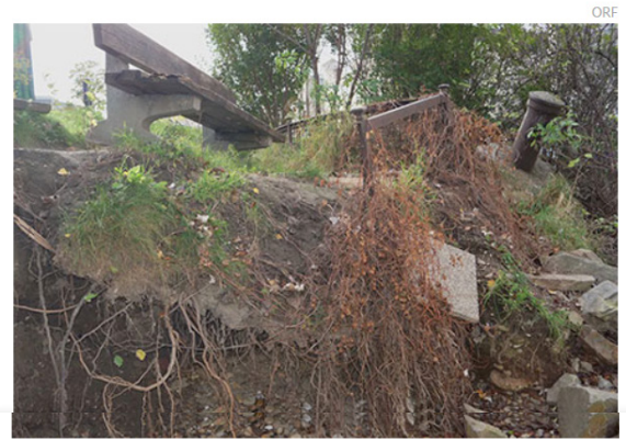
Der Uferbereich war unterspült
