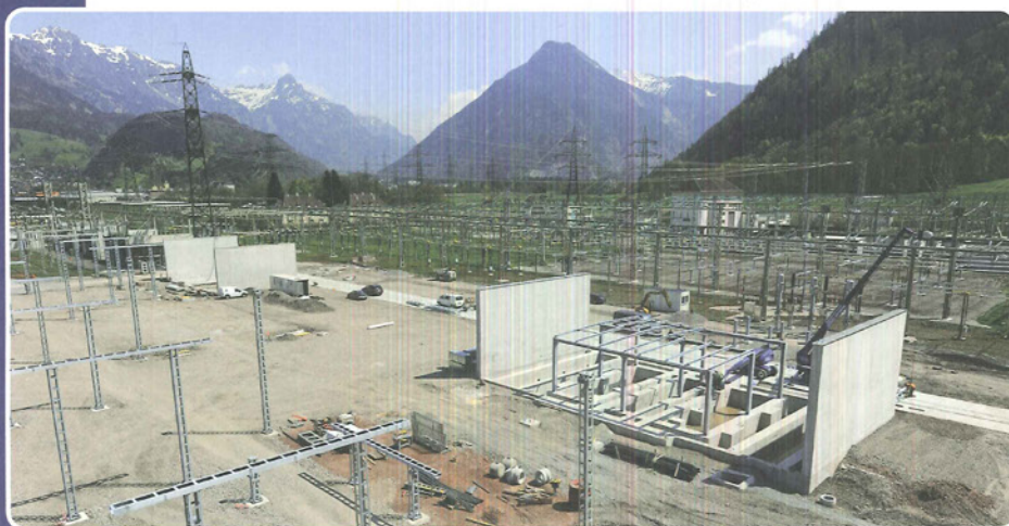
Die 220- und 380-kV-Anlagen in Bürs werden um jeweils ein Schaltfeld erweitert.
