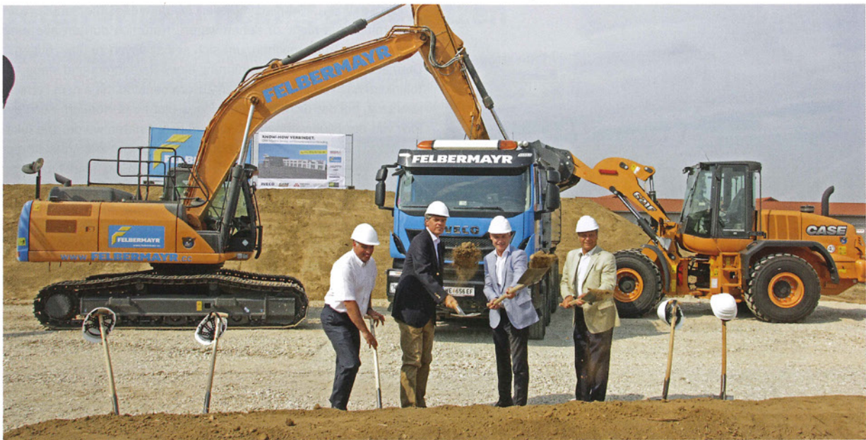
(v.l.) Richard Reder, Geschäftsführer Magirus Lohr, mit den beiden Iveco Geschäftsführern Karl-Martin Studener und Martin Stranzl, sowie dem Geschäftsführer von Case Construction Equipment, Othmar Mitterlehner, beim offiziellen Spatenstich
