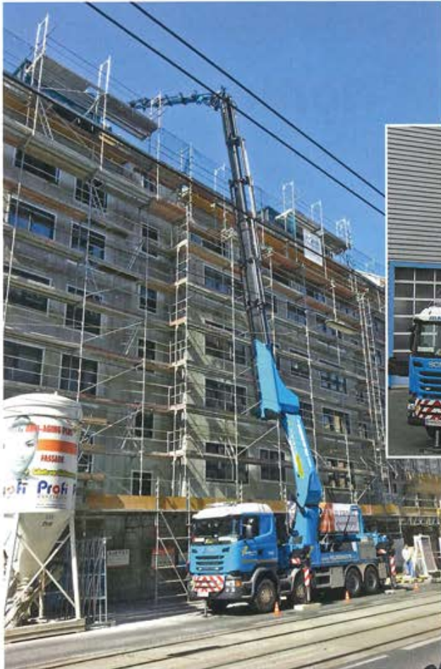
Der neue PK 200002 L SH mit einer hydraulischen Reichweite von 45,3 Metern und einer Hubhöhe von fast 50 Metern im Einsatz bei Felbermayr
