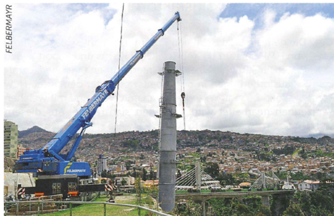
Felbermayr war in Bolivien an der Errichtung des weltgrößten City-Seilbahn-Netzes beteiligt
