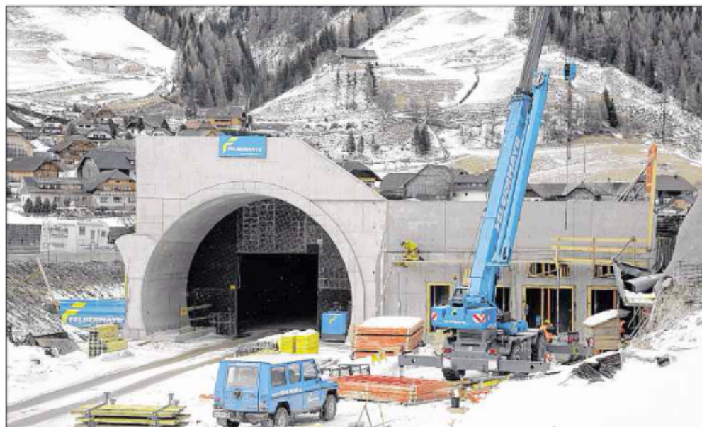
Derzeit wird an der ersten Röhre der Einhausung gearbeitet. Die Asfinag investiert 67 Millionen Euro.
