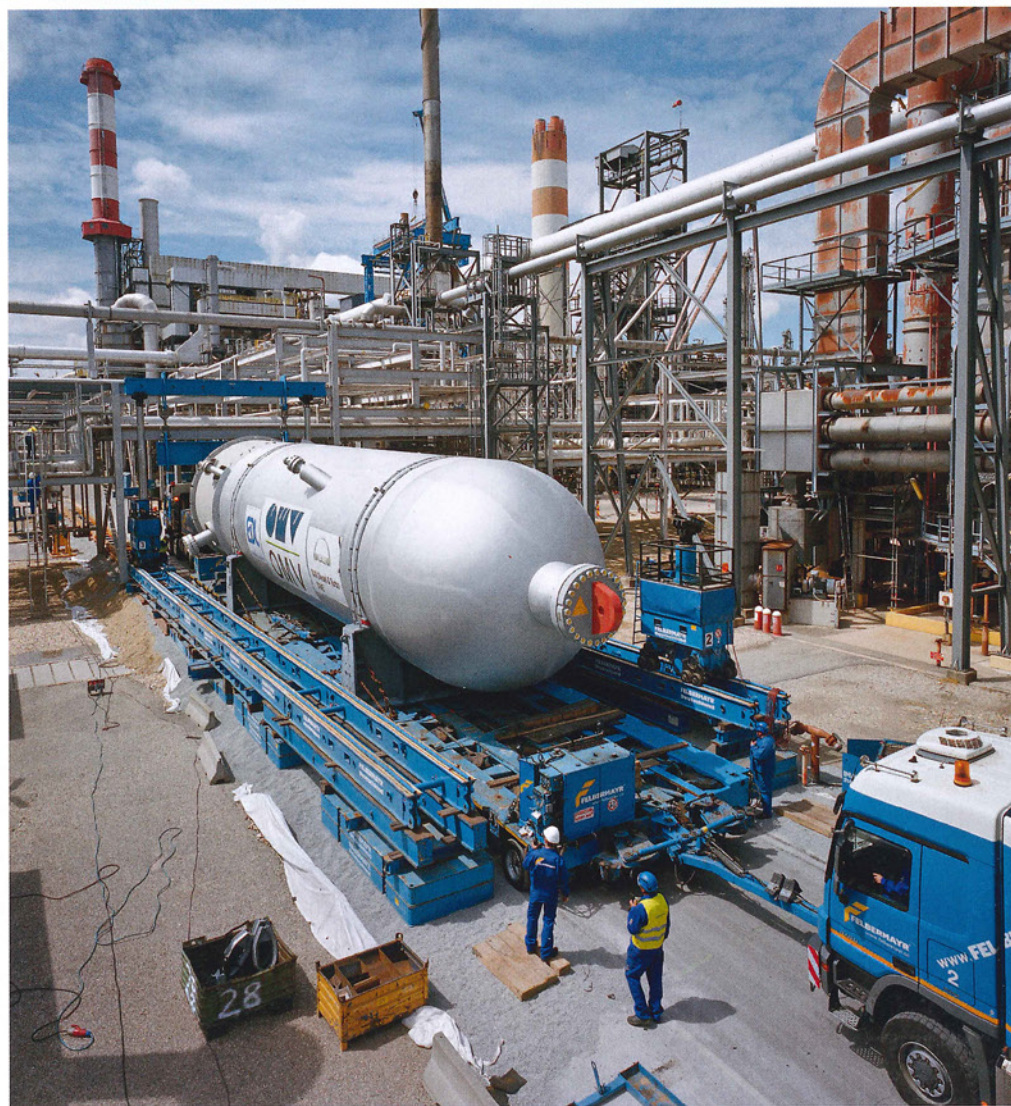
Nur per Verschiebesystem konnte die Kolonne die Rohrleitung passieren.
