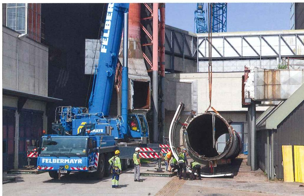
Am Boden angekommen, wurden die Turmsegmente zerkleinert und dem Recyclingprozess zugeführt.
