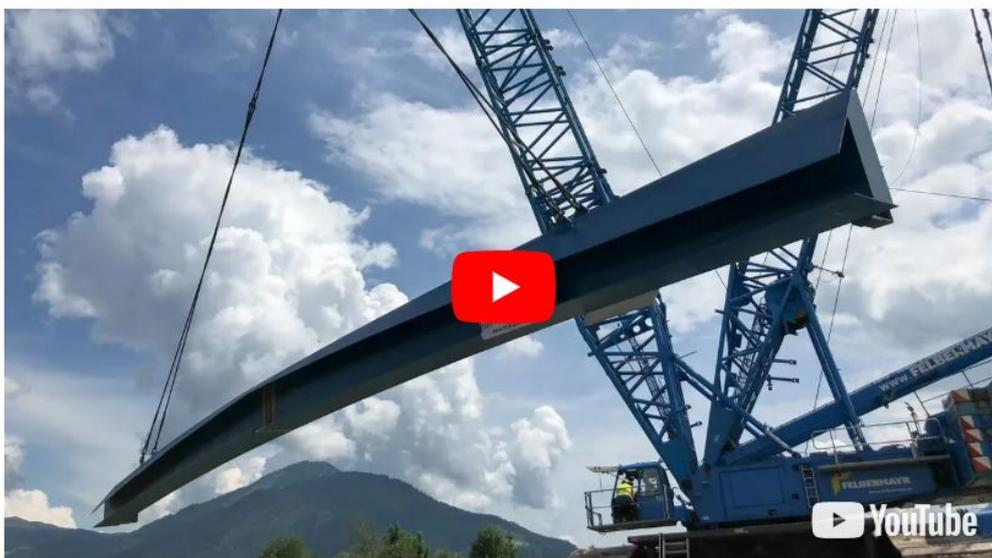
Es ist wie Lego-Spielen in enormen Dimensionen: In den vergangenen Tagen wurden die beiden Stahlhauptträger für die neue Mayereinödbrücke in Zell am See (Pinzgau) aus vier riesigen Teilen zusammengesetzt und am Donnerstag mit einem Spezialkran eingehoben. Insgesamt wiegt die neue Fertigteilbrücke 220 Tonnen und ist ein weiterer Schritt in Richtung [Hochwasserschutz im Zeller Becken](#).
