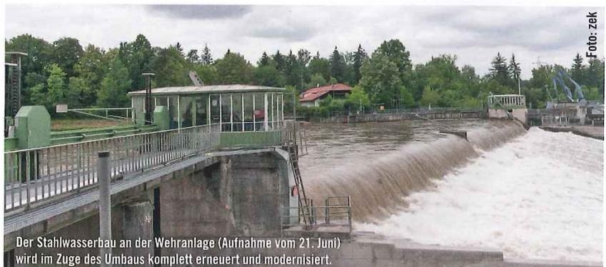
Der Stahlwasserbau an der Wehranlage (Aufnahme vom 21. Juni) wird im Zuge des Umbaus komplett erneuert und modernisiert.
