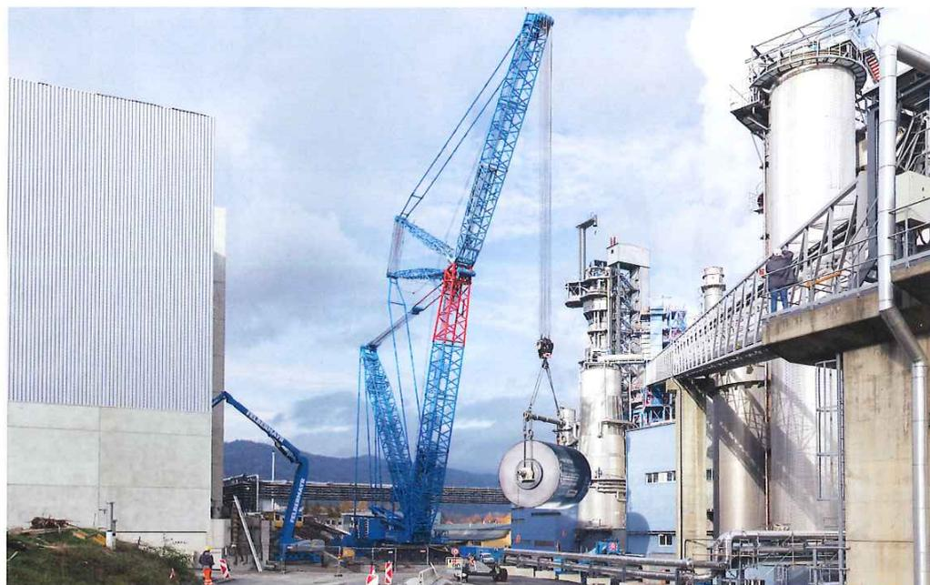
„Yankee“ aus Stahl, Trockenzylinder für Zellstoff Pöls
