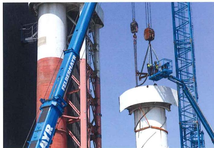
Nach dem Abstellen der Turmsegmente in der Vertikalen wurden sie unter Einsatz einer Arbeitsbühne am 350 t-Mobilkran angeschlagen, der sie horizontal am Boden ablegte.
