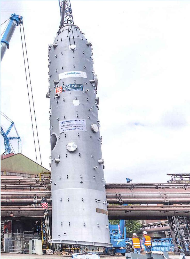
Der bestehende Gichtgaswäscher dient zur Gasreinigung im Hochofenprozess und wurde gemeinsam mit dem HO-A Anfang der 70'er Jahren errichtet und ist seit 1977 kontinuierlich in Betrieb. Nach 42 Betriebsjahren wurde der Wäscher nun 2018 im Zuge der Zustellung HO-A vollständig erneuert.
