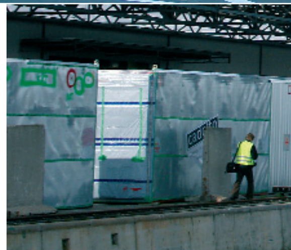
Mehr als 600 Straßentransporte in weniger als drei Monaten waren notwendig um die Krankenhausmodule termingerecht zu liefern.
