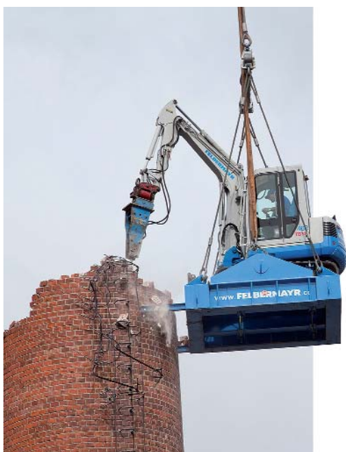
Mittels zweier I-Träger wurde das Hebeplateau mit dem Bagger stabilisiert.
