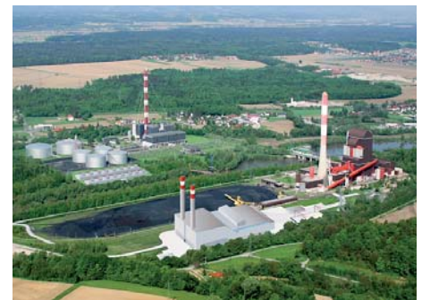
Ende 2011 wird das Gas- und Dampfkraftwerk Mellach mit einer installierten Leistung von 832 Megawatt Strom und bis zu 400 Megawatt Fernwärme in Betrieb gehen.
