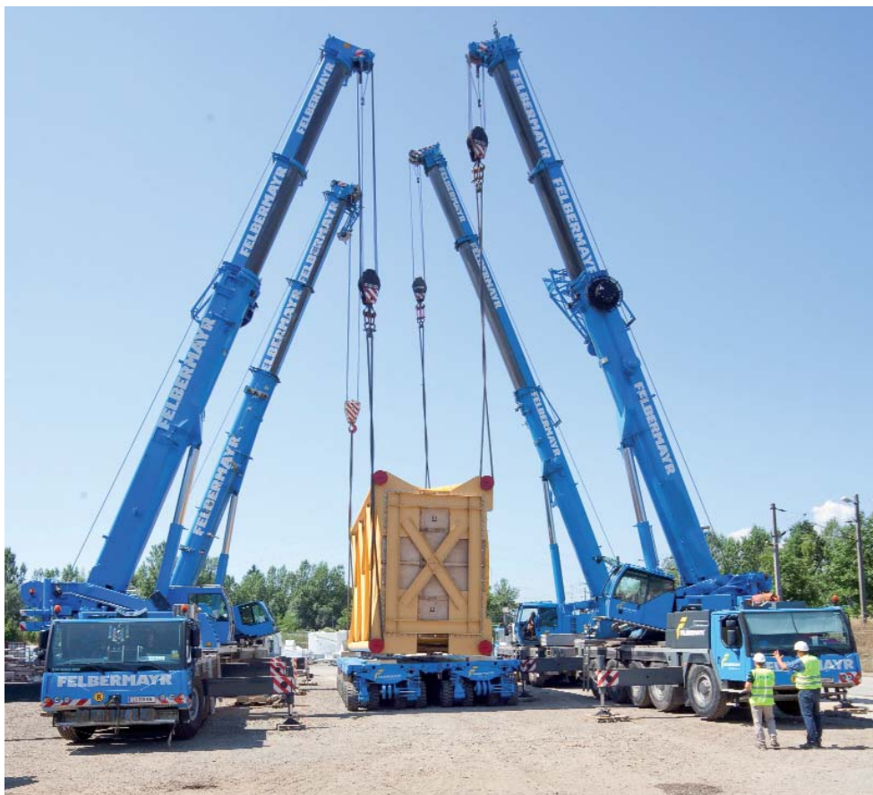
Für den Umschlag von zwei Kondensatoren kamen vier Mobilkrane gleichzeitig zum Einsatz. Das war nötig, um die je 88 Tonnen schweren Komponenten vor dem Ablegen auf dem Selbstfahrer um neunzig Grad ins Hochformat drehen zu können.
