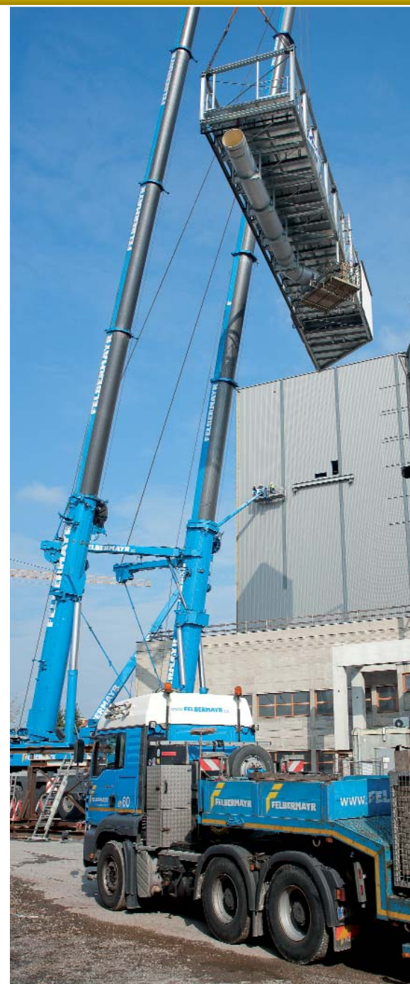
Pentru ridicare, modelul LTM 1500 a fost echipat cu ancoraj în Y și 160 de tone de balast. Pentru macaraua de urmărire a traseului au fost necesare exclusiv 72 de tone.
