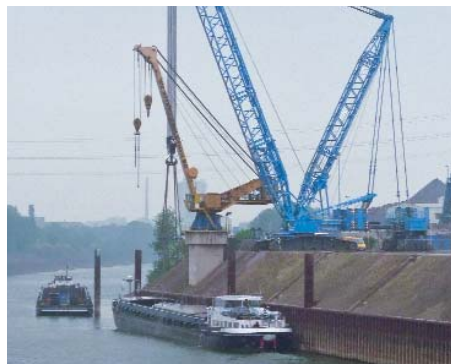
Transformatorul a fost transbordat în portul de mărfuri grele Felbermayr din Krefeld.
