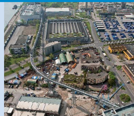
Transportul carburantului de la instalația de pregătire la uzina electrică se realizează prin intermediul unei instalații de transport de 460 metri.
