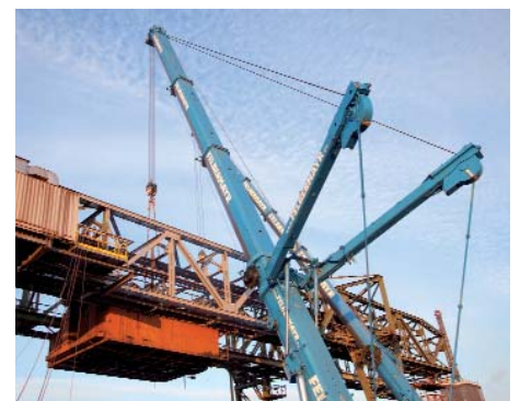
Die alte Laufkatze hatte mit 69 Tonnen wesentlich weniger Gewicht als die neue.
