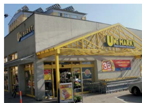
„Unimarkt” din Wels înainte de începerea reabilitării fațadei.
