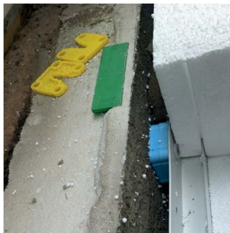
Placa de izolație pentru montaj Capatect PS se „acroșează” în despărțiturile prefabricate din sistemul de șine.
