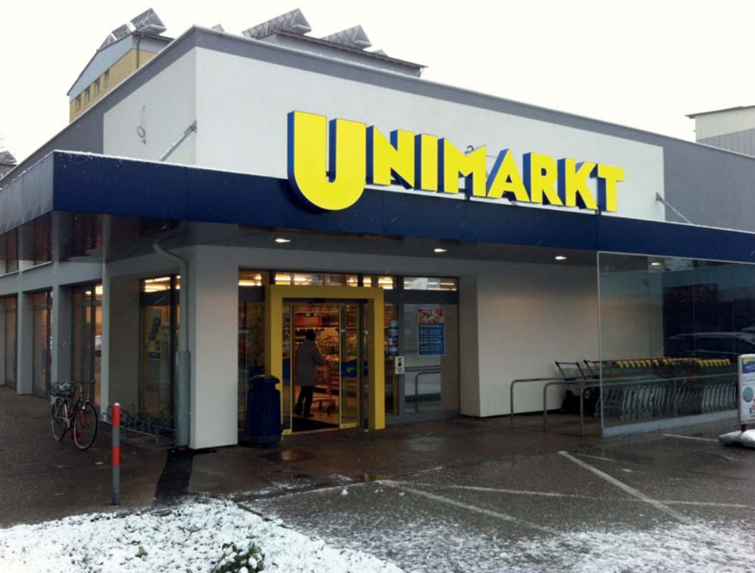
„Unimarkt” din Lindenstraße Wels după reabilitarea reușită a fațadei.
