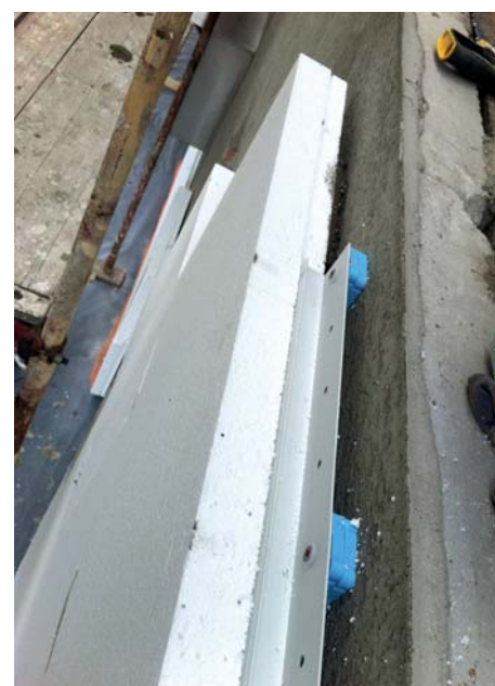
Cu sistemul de șine Capatect se pot cașera denivelările și zonele cu probleme și se poate obține o suprafață WDVS complet „plană”.
