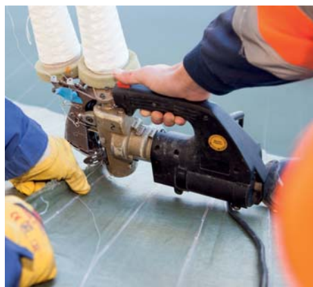
Nach dem Verfüllen der Luftmatratzen mit Beton wurden die Öffnungen vernäht.
