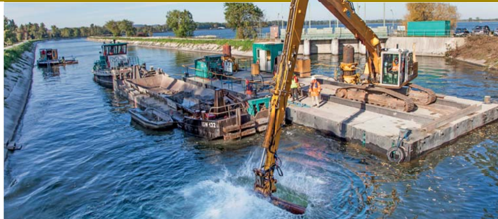
Für das Profilieren der bis zu sieben Meter tiefen Gewässersohle kamen Langstielbagger zum Einsatz.
