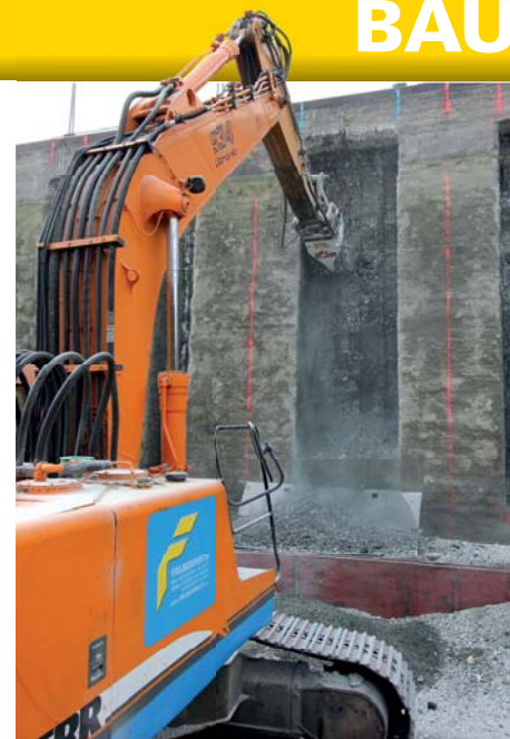
Zu Beginn der Sanierungsarbeiten wurde der bestehende Spritz- und Stampfbeton mittels Fräskopf entfernt.
