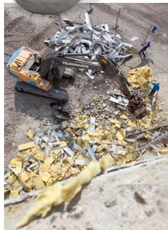
Die angefallenen Baurestmassen wurden bereits vor Ort entsprechend ihrer Wiederverwertbarkeit sortiert.
