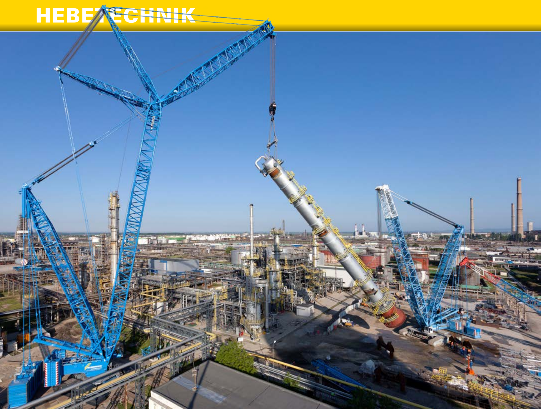
Für den Hub der 358 Tonnen schweren Kolonne wurden die beiden Krane auf ein Gesamtgewicht von 1.788 Tonnen aufballastiert.
