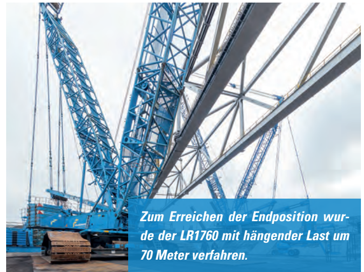
Die bis zu 50 Meter langen Kranbauteile wurden im Felbermayr-Schwerlasthafen angeliefert und mittels Selbstfahrer und teleskopierbarem Tieflader zur Baustelle transportiert.
