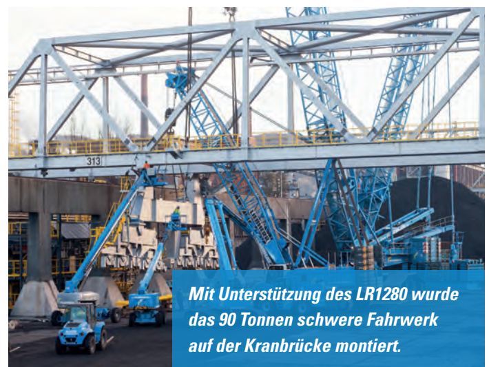
Zum Erreichen der Endposition wurde der LR1760 mit hängender Last um 70 Meter verfahren.
