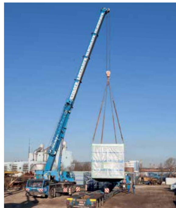
81 din totalul de 210 module de spațiu au fost depozitate în portul de mărfuri grele Felbermayr din Linz între timp și au fost transportate „just in time” la locul de construcție..
