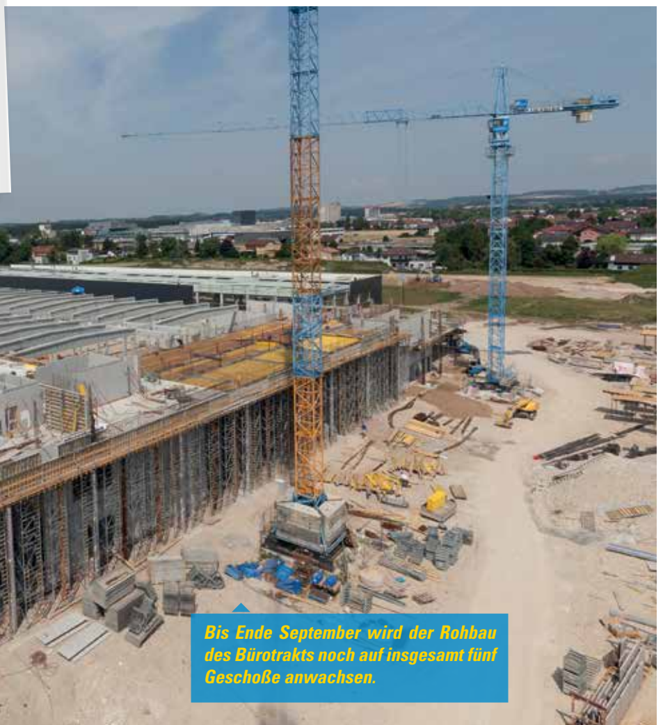
Im April 2018 soll das neue Gebäude bezugsfertig sein.
