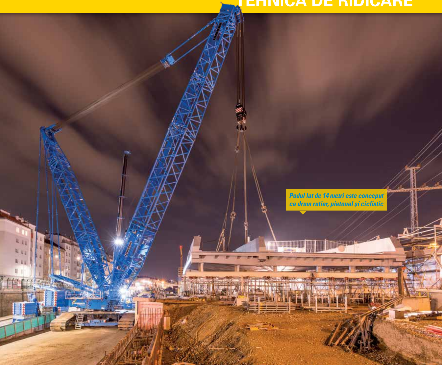
Macaraua cu șenile a fost echipată cu o greutate de balast de 270 de tone
