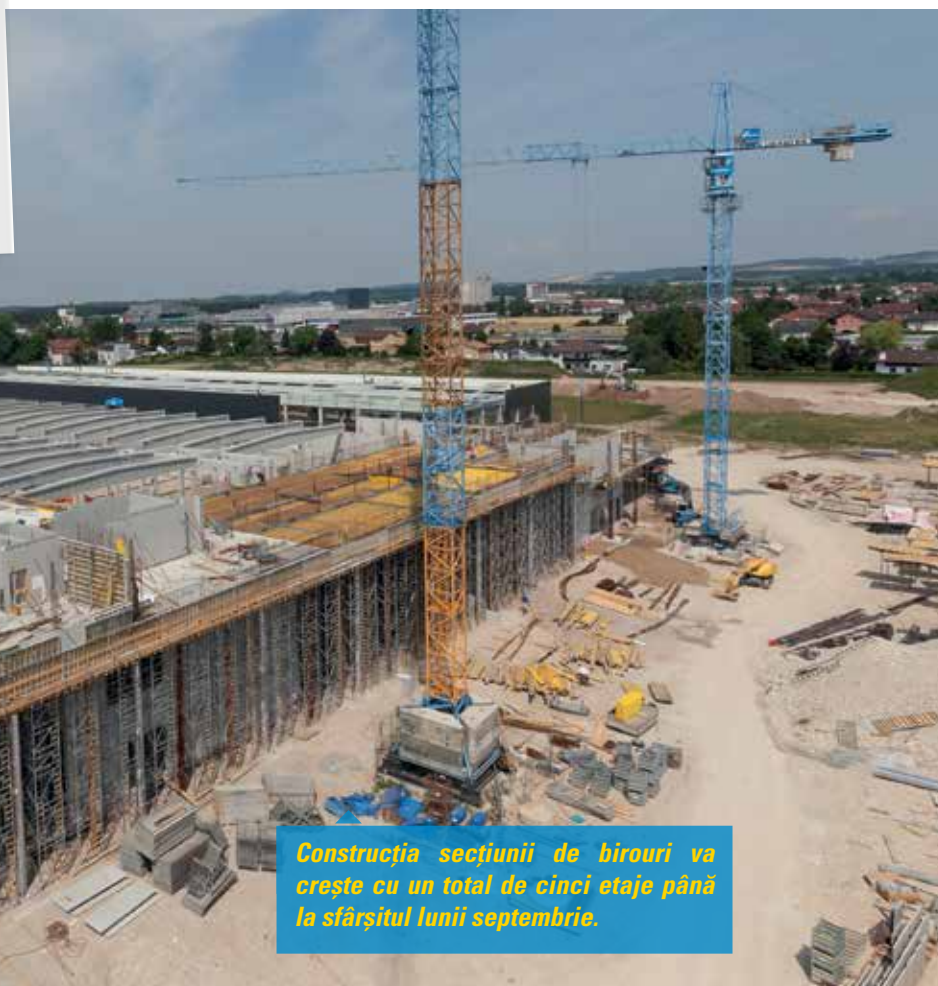
Clădirea cea nouă trebuie să fie finalizată până în aprilie 2018
