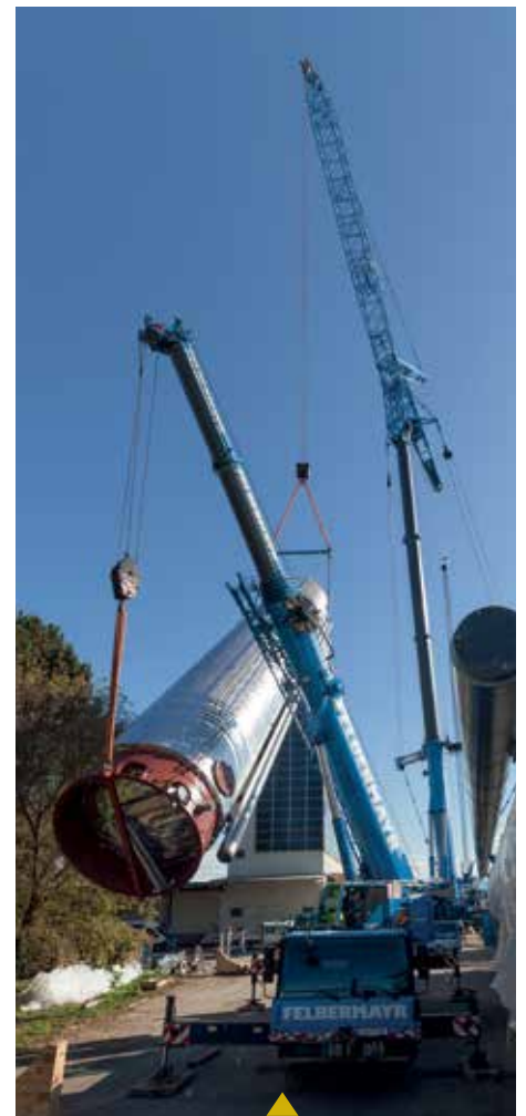
Zum Aufdrehen der Behälter kam ein LTM 1100 als Nachführkran zum Einsatz.
