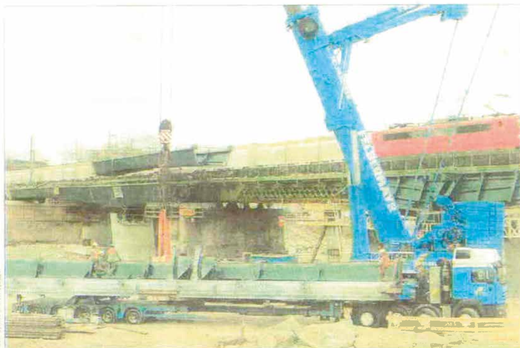
Der gigantische 500-Tonnen-Kran bei der Arbeit an der Eisenbahnbrücke. Im Juni soll sie fertig sein.
