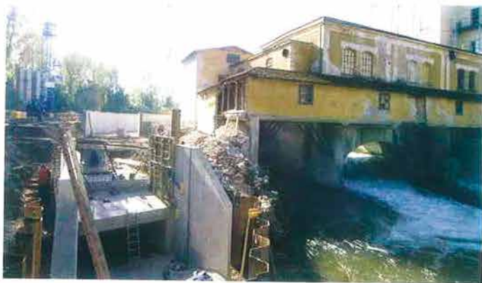
Für die Errichtung des Unterwasserkanals samt Krafthaus und Saugrohrtrichter wurde der betreffende Bereich mit Spundwänden gesichert
