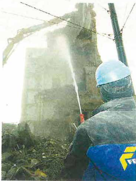
Abbrucharbeiten an der EAG-Zentrale
