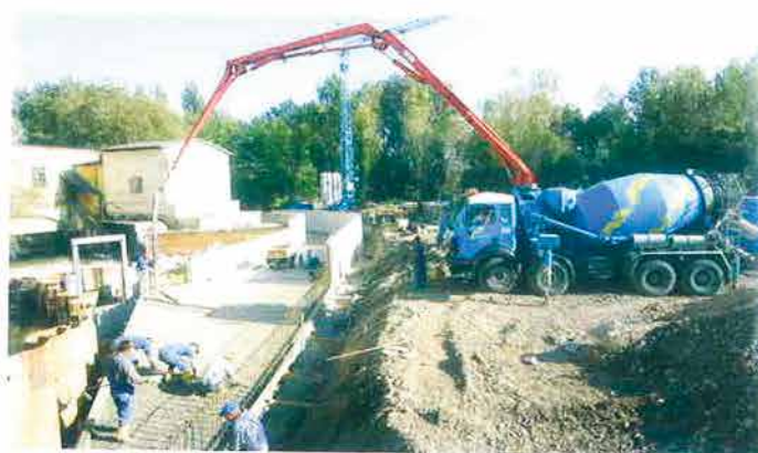
Mit der Betonage des Einlaufkanals wurde der letzte Bauabschnitt in Angriff genommen
