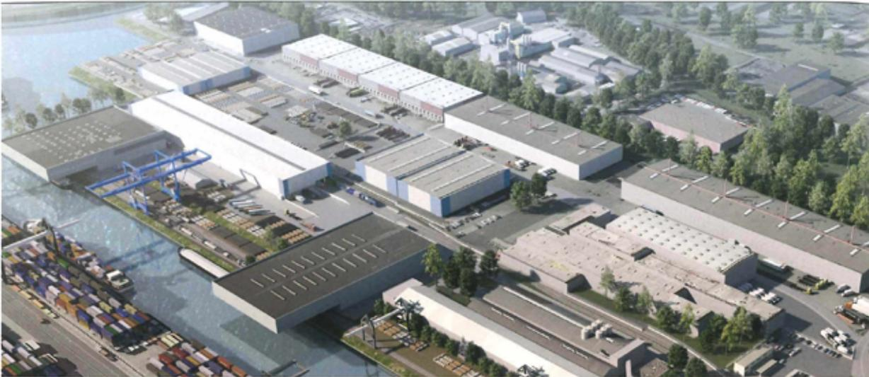
Simulation des Baus der neuen 9.180 qm großen Halle mit den Abmessungen 219 x 43,40 m, die zwei 40 t Kräne erhält, und mit zwei Halbzuggleisen und Lkw befahrbar ist und oberhalb der linken wasserüberkragenden Halle ab 2020 gebaut wird | Bild: duisport
