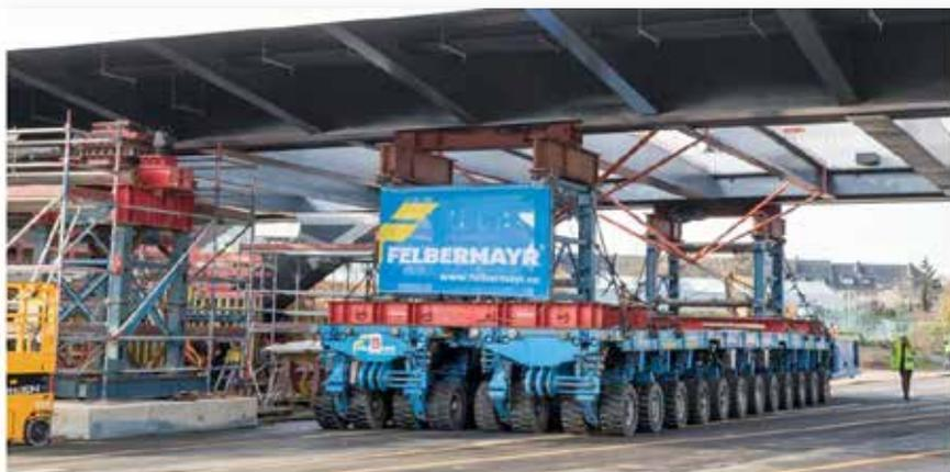
Zwei dieser Modulartransporter mit je 96 Rädern bewegen die 750-Tonnen-Brücke Zentimeter für Zentimeter
