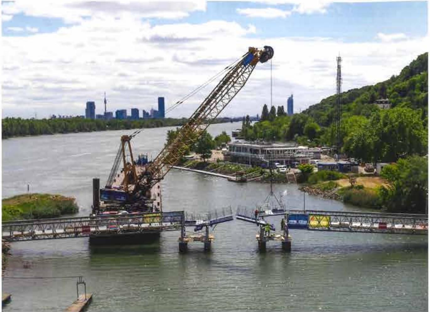
Für die Errichtung einer temporären Klappbrücke für den Fußgänger- und Radverkehr war im Mai das Kranschiff vom Felbermayr-Wasserbau im Einsatz. Nötig wurde der Einsatz aufgrund einer Straßensanierung im Bereich des Kuchelauer Jachthafens zwischen Wien und Klosterneuburg.
