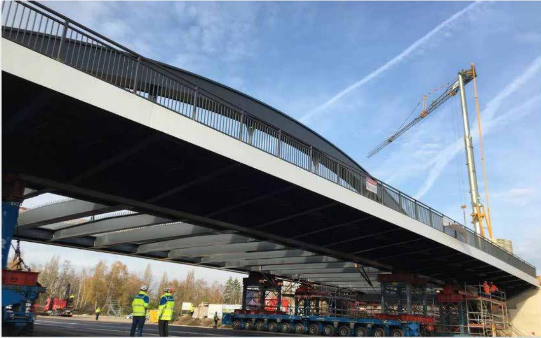
Die 750 Tonnen schwere Brücke war in den letzten Wochen neben der Baustelle zusammengebaut worden. Die neue Brücke hat zwei Fahrspuren pro Richtung sowie getrennte Spuren für Fußgänger und Radfahrer. Durch die Brücke bekommt der Heerdter Lohweg einen direkten Anschluss an die B7. Bis der in Betrieb geht, wird es allerdings noch ein gutes Jahr dauern.
