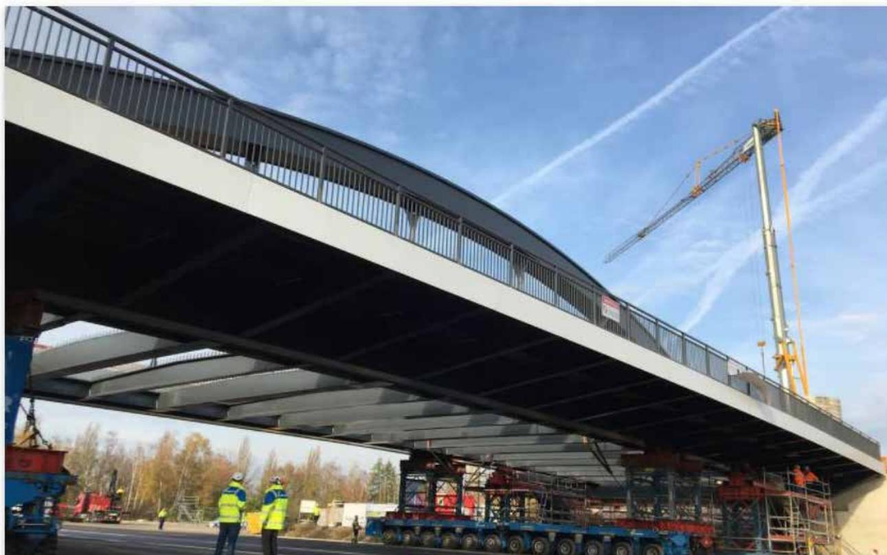
Die 750 Tonnen schwere Brücke war in den letzten Wochen neben der Baustelle zusammgebaut worden. Die neue Brücke hat zwei Fahrspuren pro Richtung sowie getrennte Spuren für Fußgänger und Radfahrer. Durch die Brücke bekommt der Heerdter Lohweg einen direkten Anschluss an die B7. Bis der in Betrieb geht, wird es allerdings noch ein gutes Jahr dauern.
