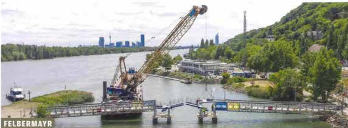
Das Kranschiff von Felbermayr-Wasserbau bewährte sich beim Einschlagen der acht Dalben und beim Einheben der Brückenteile mit einem Gewicht von bis zu 20 t.
