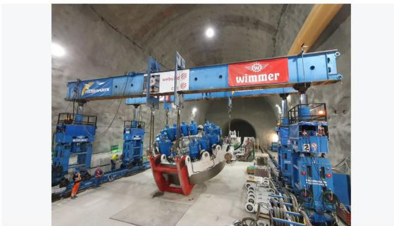
In der Montagekaverne wurden die Einzelteile mittels 1.000-Tonnen-Hubgerüst durch den Felbermayr Bereich Engineered Solutions in Position gebracht. - © Felbermayr/Müller
