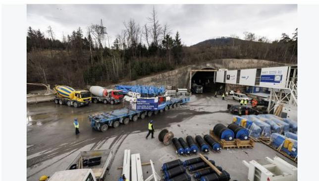
Felbermayr transportierte für den Bau des 55 Kilometer langen Brenner-Basistunnels zwei riesige Tunnelbohrmaschinen. Allein für eine der beiden Tunnelbohrmaschinen waren 97 Straßentransporte erforderlich. - © Felbermayr/Müller
