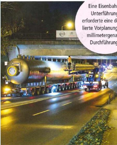
ter Hub vom Tieflader auf die Fundamente möglich wurde. Die finale Platzierung erfolgte dann mit einer eigens gebauten Verschubbahn auf schweren Trägern über 5 m. «Wir hatten in der Breite nur 25 mm Spielraum», so Ibraimi. Nach der Demontage der Verschubbahn wurde der zweite Hydrolizer eine Woche später auf die Betonfundamente gehoben und fixiert.
