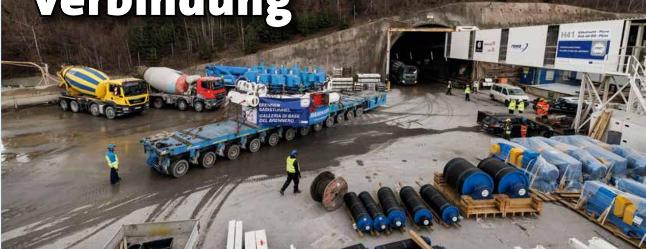
Felbermayr transportierte für den Bau des 55 Kilometer langen Brenner-Basistunnels zwei riesige Tunnelbohrmaschinen. Allein für eine der beiden Tunnelbohrmaschinen waren 97 Straßentransporte erforderlich.
