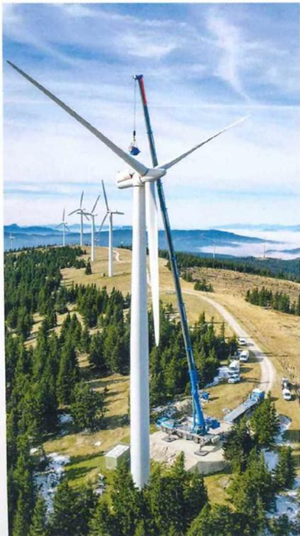
Der mit einem 90 m Ausleger bestückte Fahrzeugkran verfügt mit „WindSpeed Load Charts“ über Traglasttabellen mit höheren zulässigen Windgeschwindigkeiten. Falls beim Einsatz die am Kranausleger gemessene Windgeschwindigkeit die eingestellte Tabellenwindgeschwindigkeit übersteigt, kann der Kranführer einfach auf eine Traglasttabelle mit einer höheren zulässigen Windgeschwindigkeit umschalten und damit seine Kranarbeit oftmals weiterführen.
