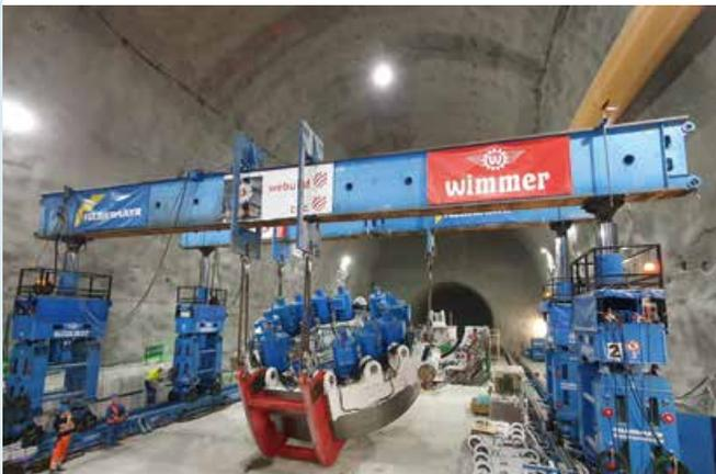
In der Montagekaverne wurden die Einzelteile mittels 1.000-Tonnen-Hubgerüst durch den Felbermayr Bereich Engineered Solutions in Position gebracht.
