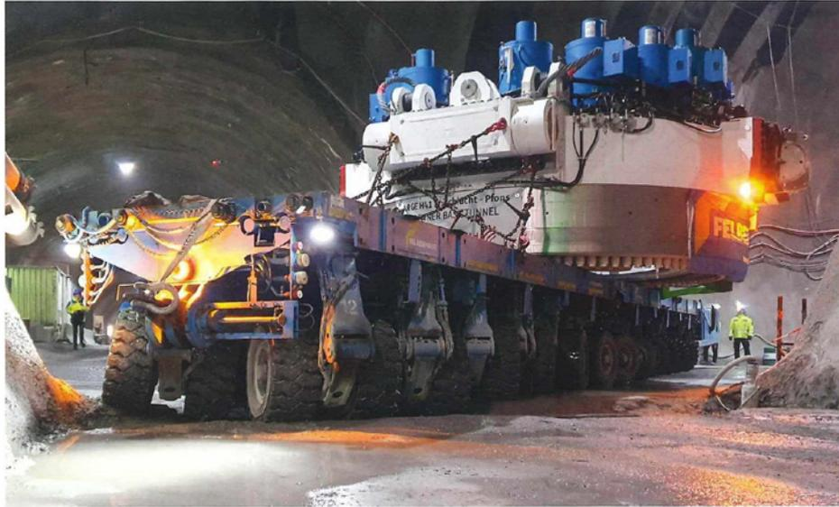
Es war mit großem logistischen Aufwand verbunden, die bis zu 270 Tonnen schweren Komponenten im engen Tunnel zu den Montagekavernen zu fahren.
