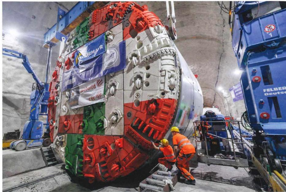
In den Montagekavernen wurden die Einzelteile nach und nach zu einem großen Ganzen zusammengefügt. Diese technisch anspruchsvollen Montagen wurden durch Engineered Solutions geplant und umgesetzt.
