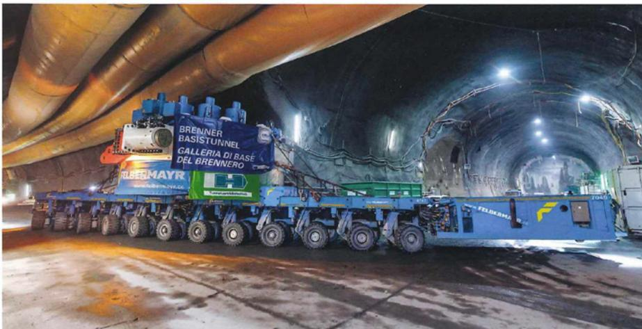
Für die Transporte wurden die Selbstfahrer SPMT von Scheuerle mit sechs, zehn oder zwölf Achsen eingesetzt.
