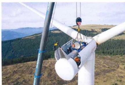
Mit seinem 90 m langen Hauptmast ist der LTM 1300-6.3 der ideale Kran für Arbeiten in großen Höhen. Für Aus- und Einbau brauchen nicht nur die Monteure Fingerspitzengefühl. Die Montage bedeutet auch für den Kranführer stundenlange Konzentration.
