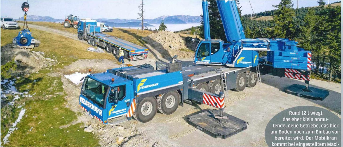
Rund 12 t wiegt das eher klein anmutende, neue Getriebe, das hier am Boden noch zum Einbau vorbereitet wird. Der Mobilkran kommt bei eingestelltem Maximalradius hier mit 42 t Ballast aus.
