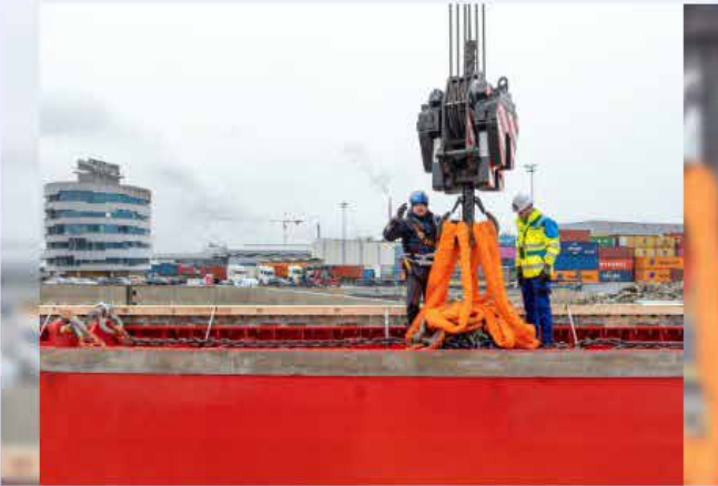
Speziell beim Einhub vom Oberteil und Aufsetzen auf den Unterteil war Millimeterarbeit gefragt.
