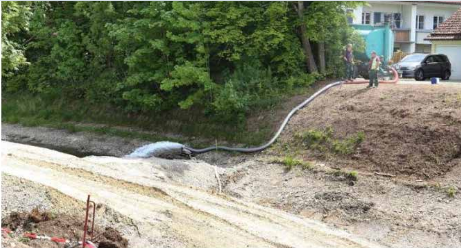
Damit er nicht austrocknet, wird ein Abschnitt des Loisach-Isar-Kanals mittels Tanklaster wieder mit Wasser befüllt. © Sabine Hermsdorf-Hiss
