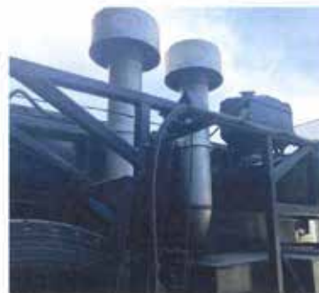
TOP AIR Zentrifugal-Schmutzabscheider schützen die Ansaugluft vor Staub.
