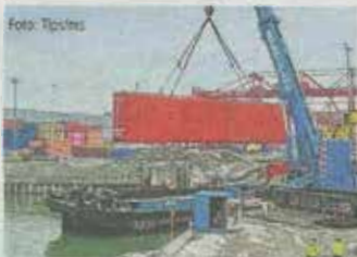
Am 8. Jänner wurde das Tor eingehoben.
