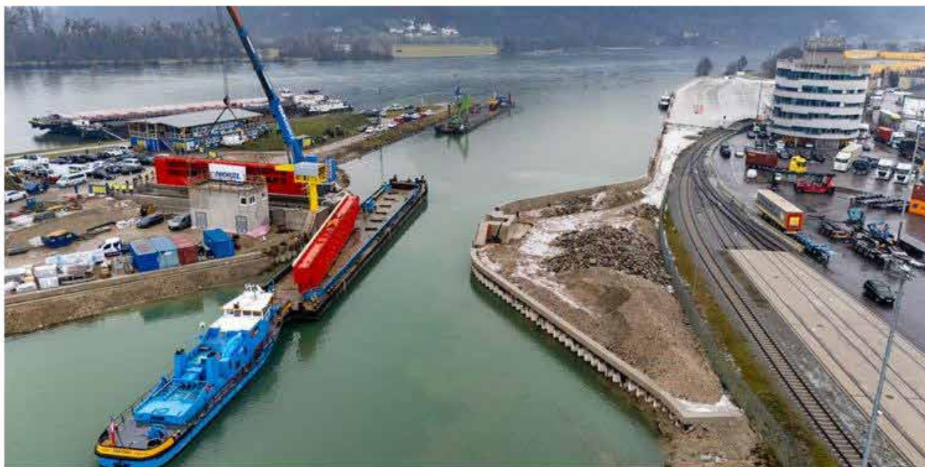
Luftaufnahme - Einheben Hafentor. Anlässlich eines Pressetermins der LINZ AG zum Thema ‚Einheben des Hafentors‘ im Rahmen des ‚Jahrhundertprojekts ‚Hochwasserschutz Hafen Linz‘ aufgenommen am 8. Jänner 2025.
