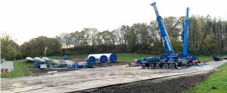
Turmteile und Windblattflügel lagern auf einem Umladeplatz an der Bundesstraße 238.
