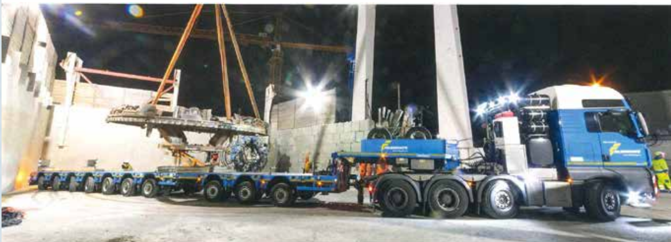
Am Ziel angekommen, hebt ein Portalkran um 3 Uhr morgens das Schneidrad vom Semi-Tiefelader.
