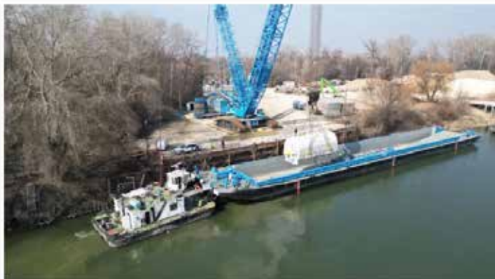
Der Generator wurde mit einem 750-Tonnen-Raupenkran auf den SPMT gehoben.
