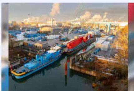
In den frühen Morgenstunden waren die beiden Hafentorteile bereit für den Transport vom Felbermayr-Schwergutterminal im Schwerlasthafen zum Handelshafen Linz.
