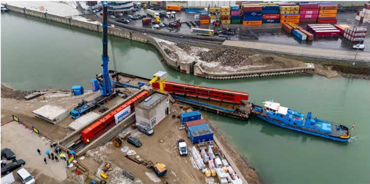
Das Einheben des 200 Tonnen schweren Linzer Hafentors beim Handelshafen. (Bild: Fotokerschi)
