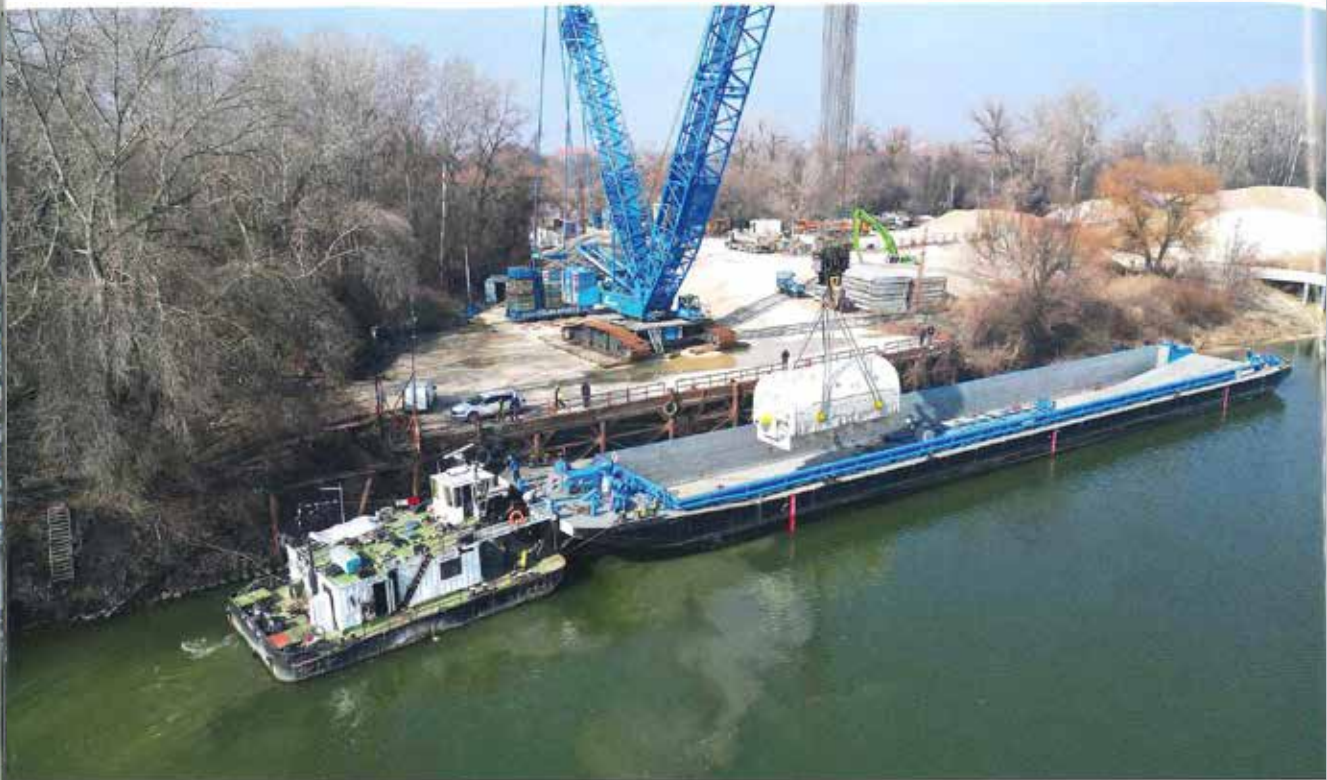
Der zweite Generator wurde mit einem 750-Tonnen-Raupenkran auf den SPMT gehoben.
