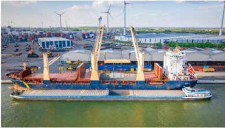
Im Felbermayr-Terminal in Antwerpen, Belgien, wurden die Generatoren vom Hochseeschiff auf ein Binnenschiff umgeschlagen.
