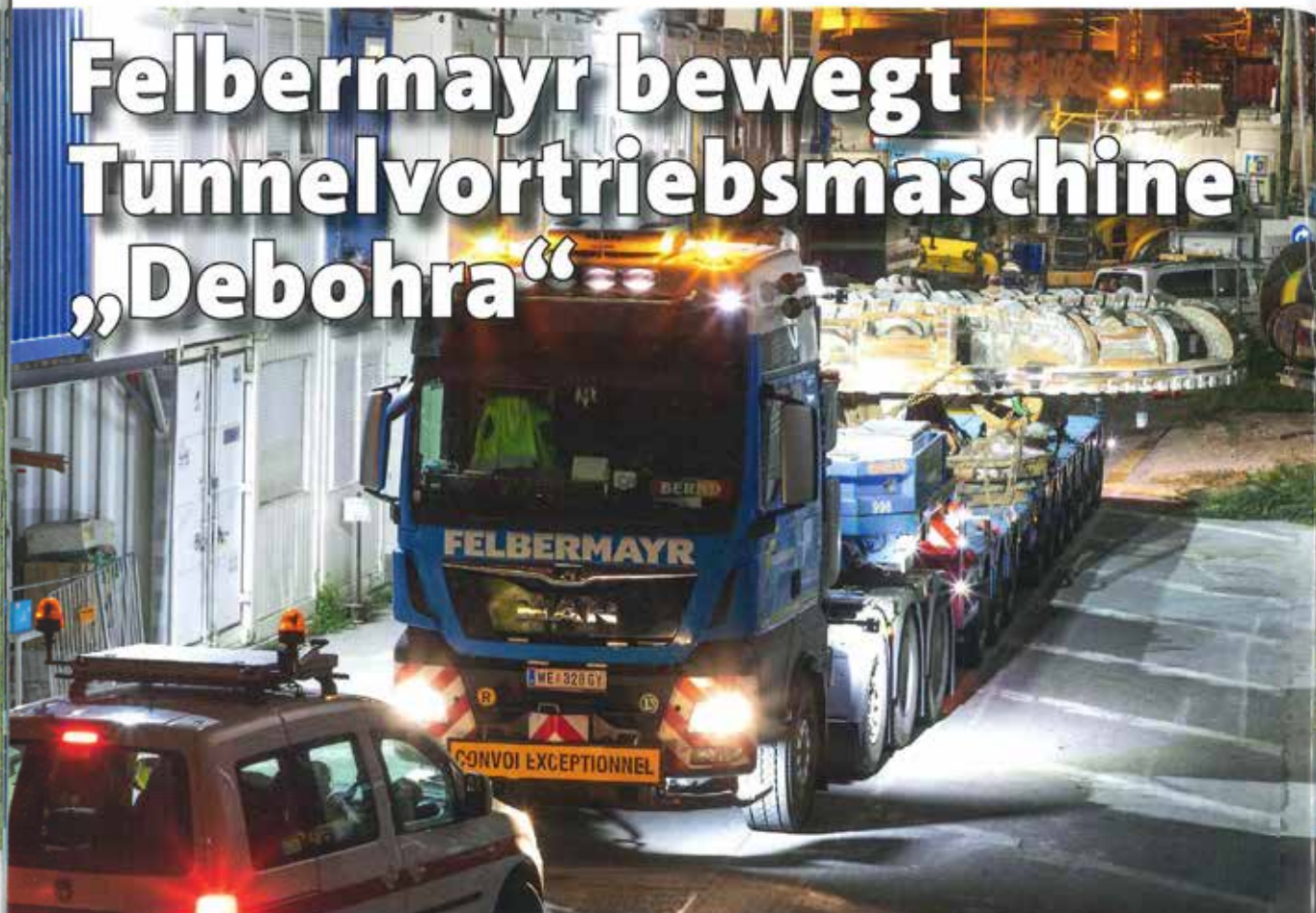
Die Vier-Achs-Zugmaschine manövriert den zehnnachsigen Semi-Tieflader rückwärts in die vorgesehene Position am Matzleinsdorfer Platz.
