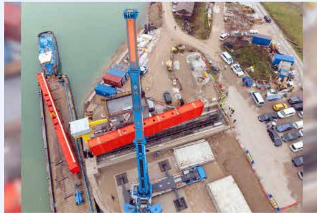
Die Mitarbeiter der Felbermayr Transport- und Hebetchnik zeigten ihre Expertise bei der Montage des neuen Hafentores.
