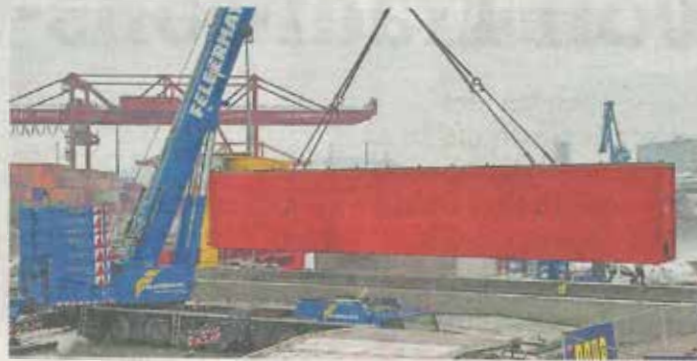
Die 200 Tonnen schwere Stahlkonstruktion soll das Industriegebiet samt angrenzender Innenstadt vor Hochwasser schützen. Foto: MeinBezirk
