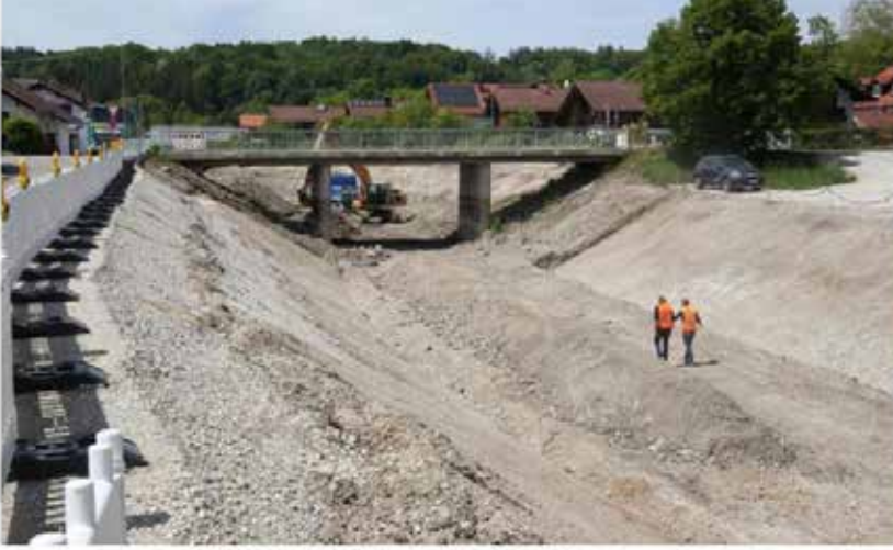
Schütter, soweit das Auge reicht. Für die Sanierung wurde das Wasser aus dem betroffenen Kanal-Abschnitt ausgelassen. © Sabine Hemsdorf-Hiss
