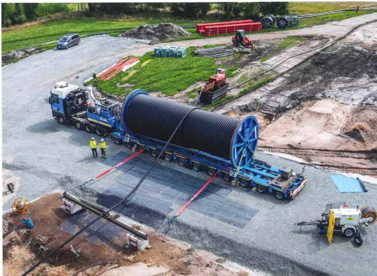
An mehreren Abspulplätzen in Deutschland hat der Abspulvorgang bereits begonnen. Ein effizienter Einsatz von Personal und Technik ermöglicht den reibungslosen Ablauf an mehreren Baustellen gleichzeitig.
