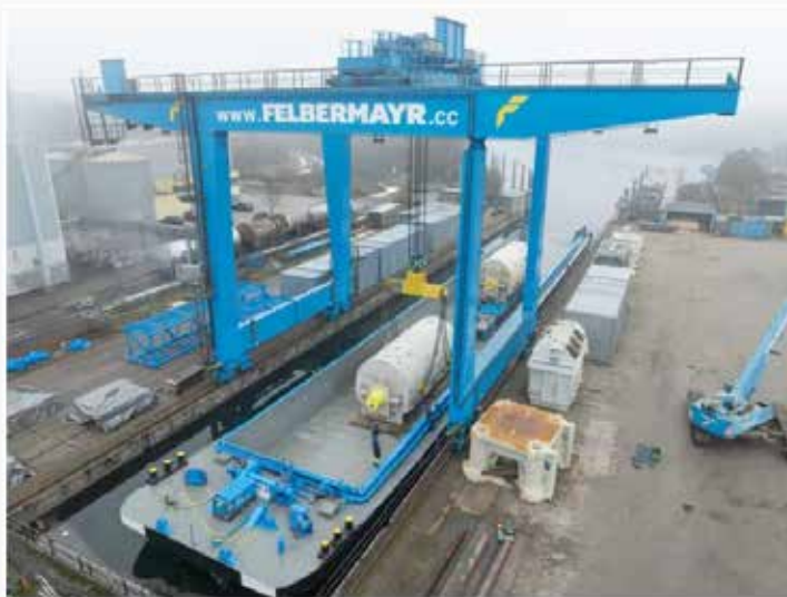
In Linz wurden die Generatoren auf den Schubleichter RoRo30 umgeschlagen – einer davon bereits auf einen SPMT.
