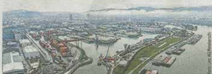
Die Toranlage soll den Linzer Handelshafen vor Überschwemmungen schützen.
