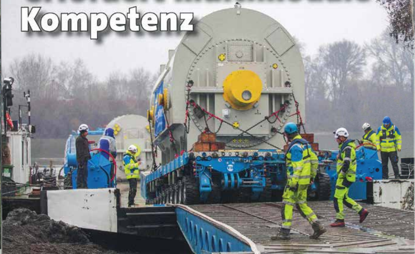
Über die RoRo-Rampe rollte der SPMT mit dem Generator aus dem Schiff aus ...
