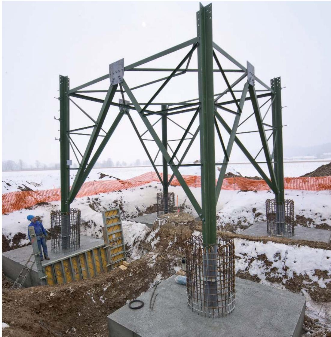
**Ein sogenanntes Einzelblockfundament besteht aus vier Fundamenten mit jeweils drei Sockeln. Der erste davon kann bis zu fünf Meter unter die Geländeoberkante reichen. In den zweiten Sockel (im Bild sichtbar) werden die Mastfüße einbetoniert. Zuletzt wird noch der über die Geländekante reichende Ziersockel betoniert.**
