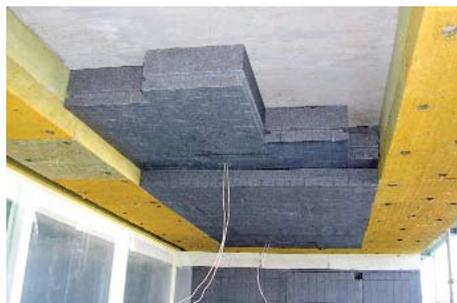
**Die zweilagige Verarbeitung des Dämmstoffes erfordert hohe Materialkenntnisse bei Kleber, Dämmstoff und Verdübelung.**
