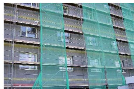
**Als Dämmstoff in den Obergeschossen wurden 22 bzw. 28 Zentimeter Lambdapor verwendet, als Armierung kam Capatect Klebe- und Spachtelmasse 190 zum Einsatz, als Deckputz Capatect CarboPor Strukturputz, Körnung 30.**
