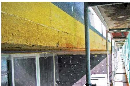
**Der normativ vorgeschriebene Brandschutzriegel aus Mineralwolle verzögert die Brandausbreitung und hält das gefährliche Abtropfen von geschmolzenen Dämmsystem-Komponenten auf.**
