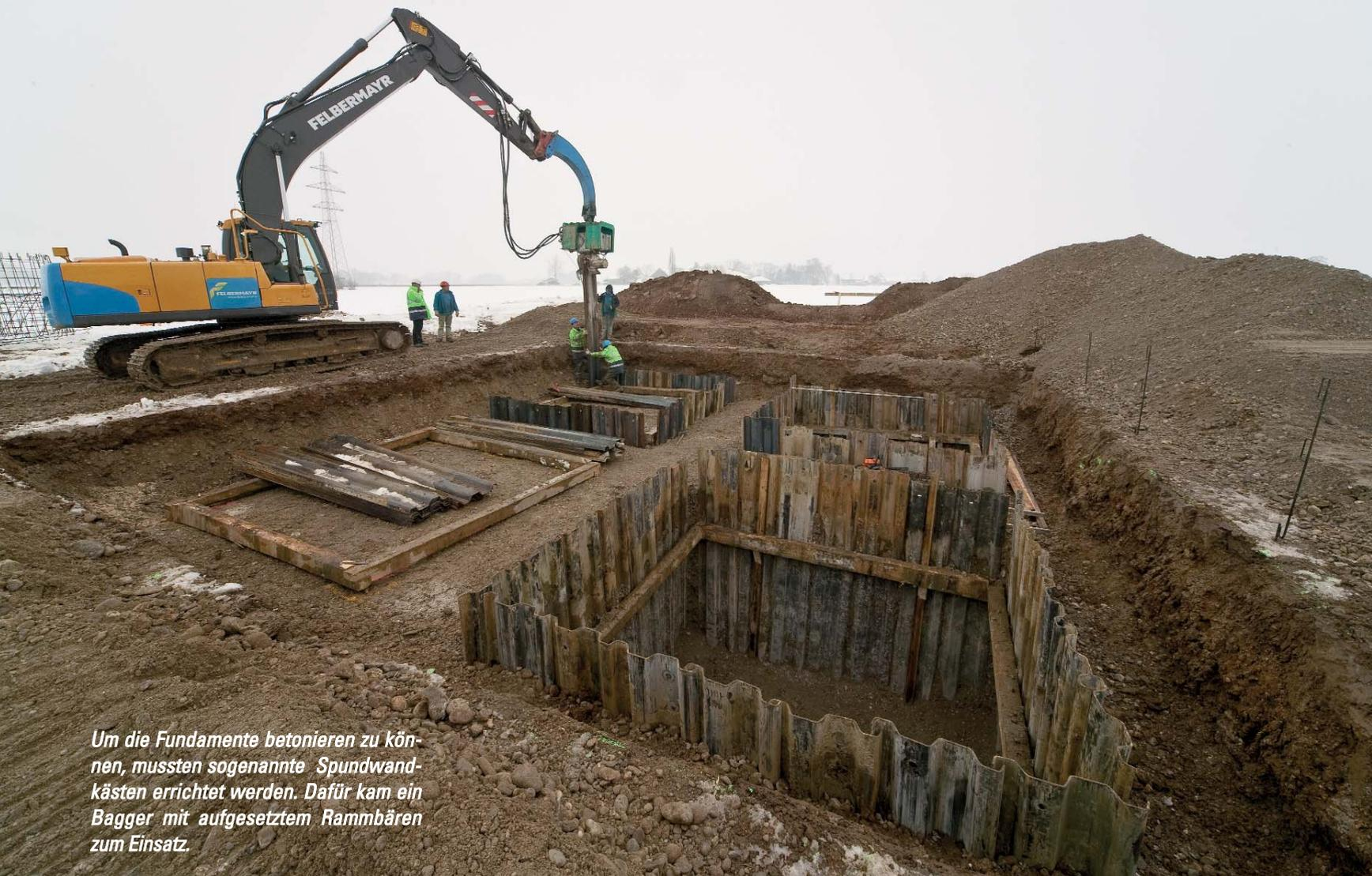
Um die Fundamente betonieren zu können, mussten sogenannte Spundwandkästen errichtet werden. Dafür kam ein Bagger mit aufgesetztem Rammhären zum Einsatz.
