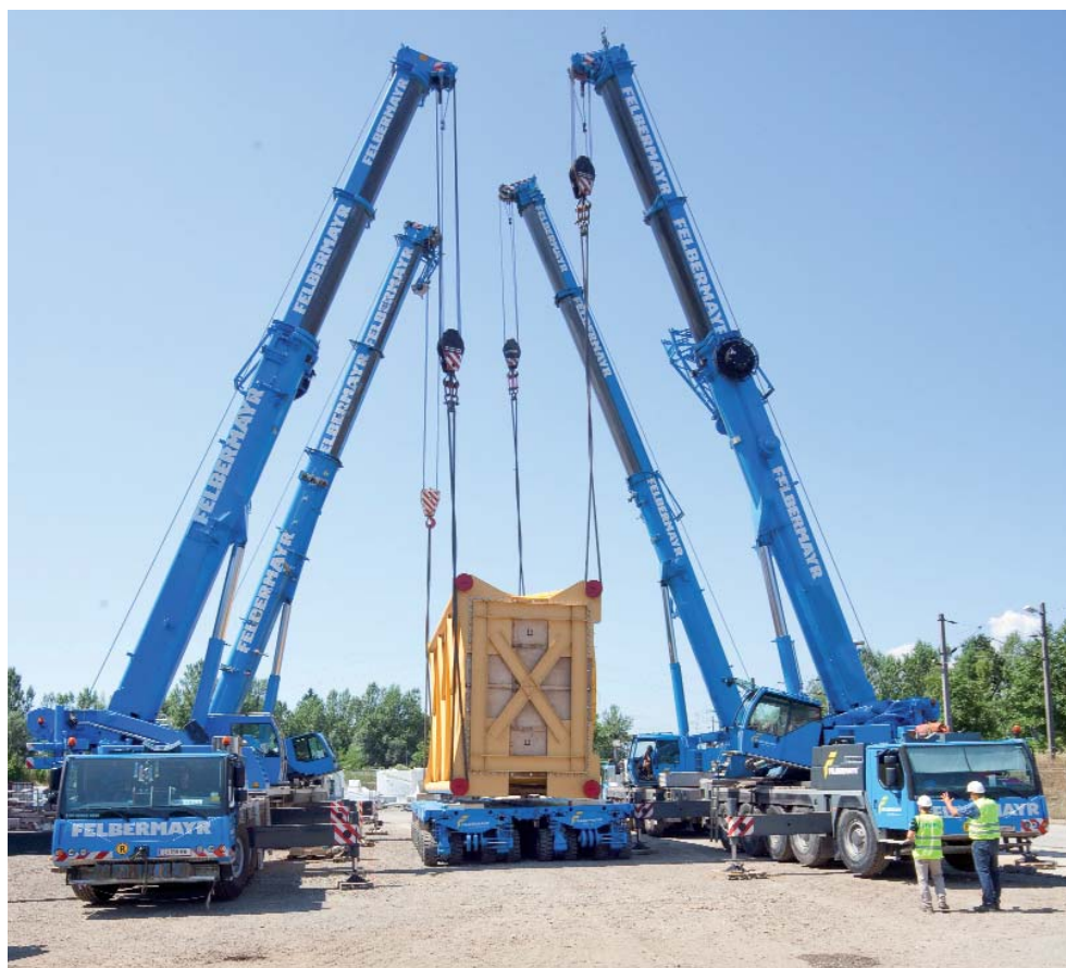
Pentru mutarea celor două condensatoare s-au folosit patru macarale mobile concomitent. Acest lucru a fost necesar pentru a putea roti cu nouăzeci de grade la verticală cele 88 tone de componente, înainte de depunerea pe vehiculul autopropulsat.
