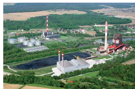
La finalul lui 2011, uzina electrică pe gaz și abur Mellach, cu o putere instalată de 832 Megawați, va debita curent și până la 400 Megawați căldură în rețeaua de termoficare.
