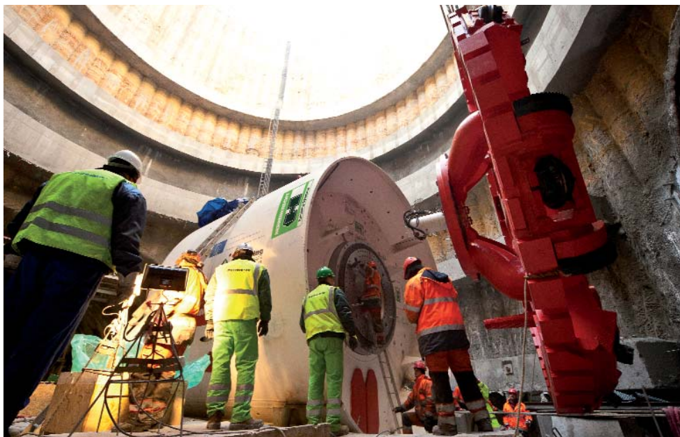
Cu utilajele moderne de forat în tunel se pot atinge viteze de înaintare în galerie de peste 300 de metri pe lună.
