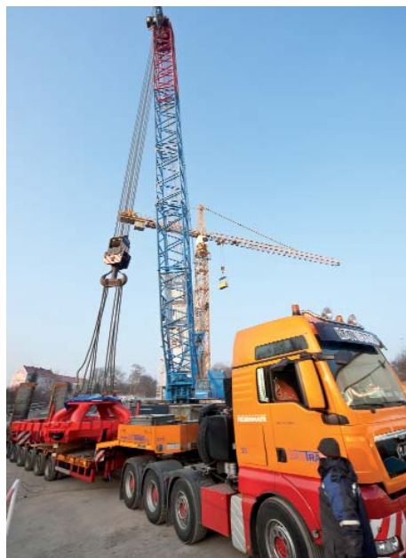
Transportul utilajului de forat în tuneluri pe șantier a fost executat de BauTrans, prin comandă de la MSG cu sediul în Kehl (D).
