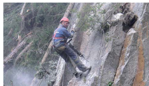
În total au fost montați 10.000 metri liniari de ancoraje.
