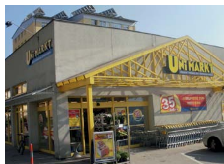
Der Welser „Unimarkt“ vor Beginn der Fassadensanierung.
