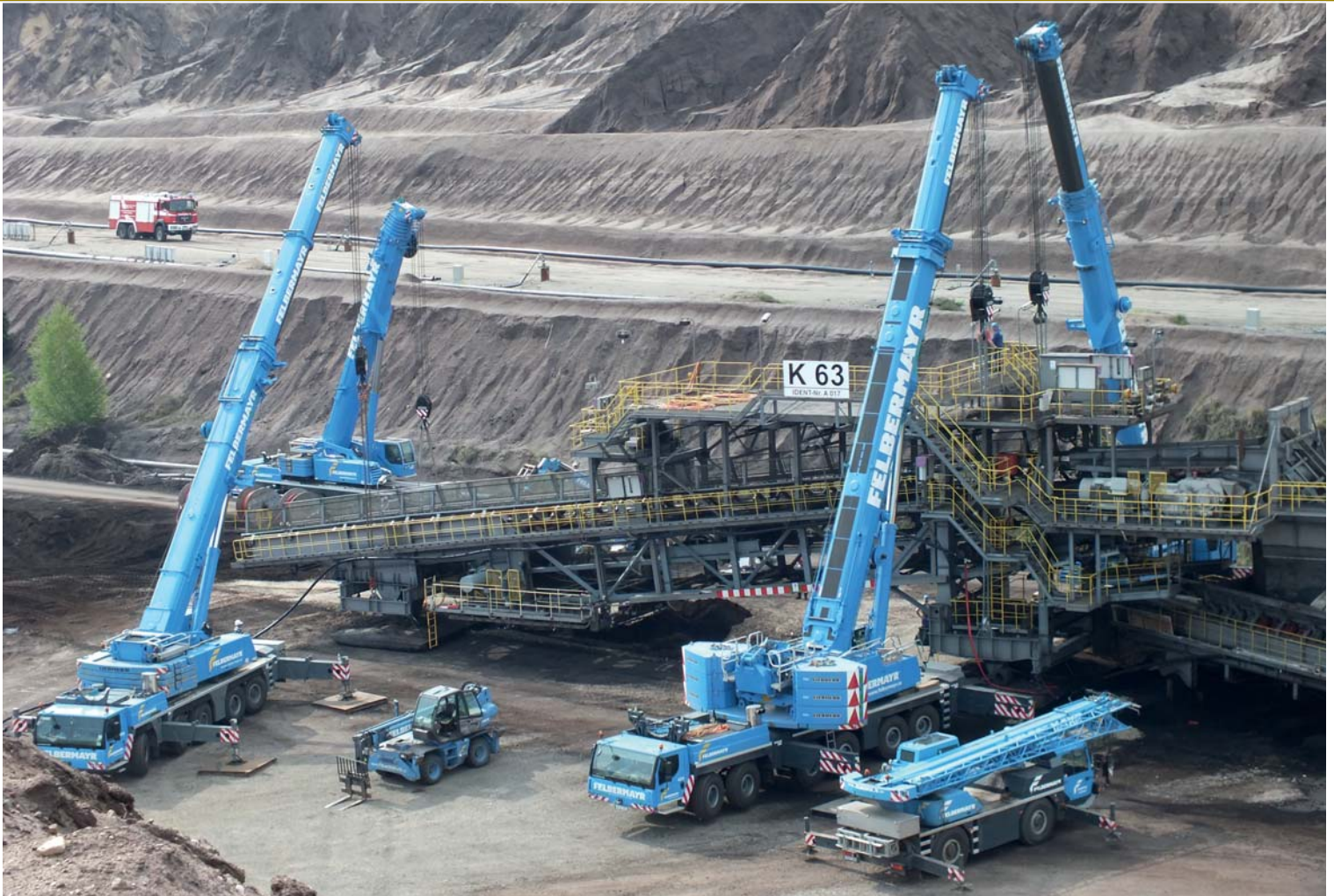
Aufgrund des Umbaus der bestehenden Kohlebandanlage musste die Antriebsstation um etwa 60 Grad gedreht werden.
