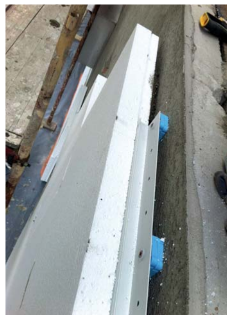
Mit dem Capatect-Schienensystem können Unebenheiten und Problemzonen kaschiert und eine völlig „plane“ WDVS-Oberfläche erzielt werden.
