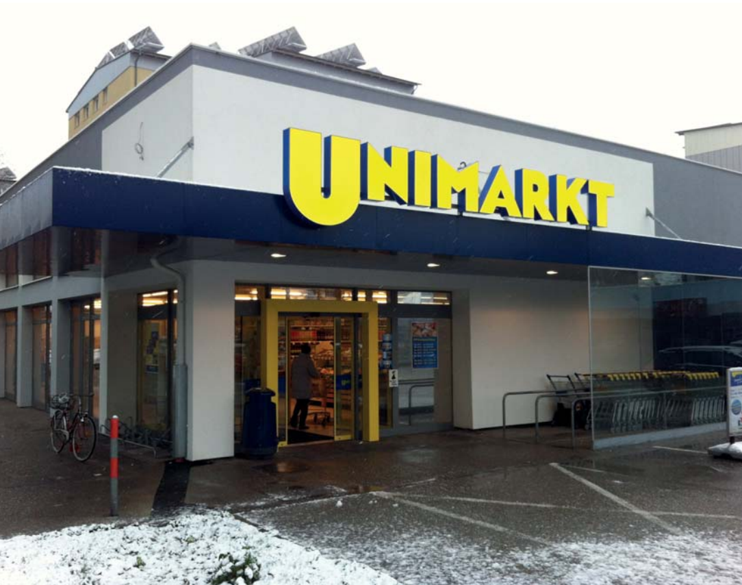
Der „Unimarkt“ in der Welser Lindenstraße nach gelungener Fassadensanierung.
