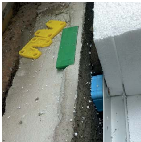
Die Capatect PS-Montagedämmplatte wird an den vorgefertigten Schlitten in das Schienensystem „eingehängt“.
