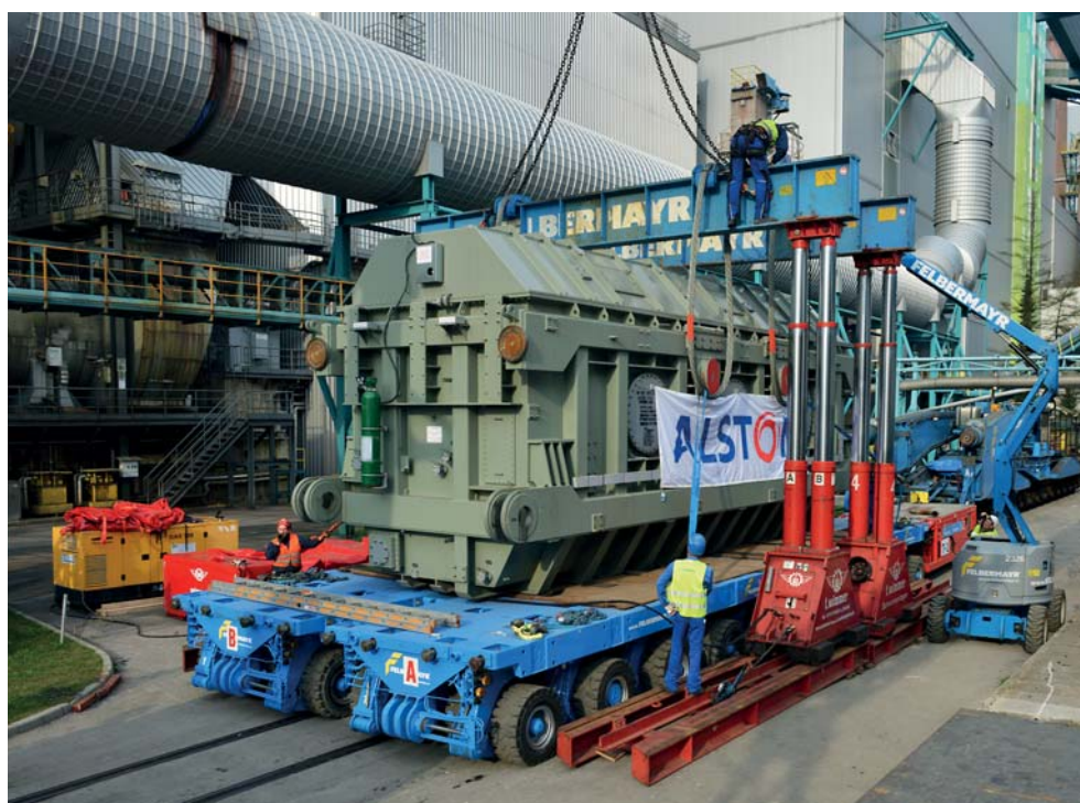
Durch Mitarbeiter des Felbermayr Tochterunternehmens Wimmer wurde der Spannungswandler vom Bahntieflader auf den SPMT (Self Propelled Modular Transporter) umgeladen.
