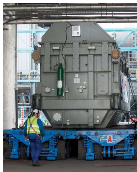
Vor der Fundamentstellung musste der Trafo noch etwa zwei Kilometer am Werks-gelände verfahren werden.
