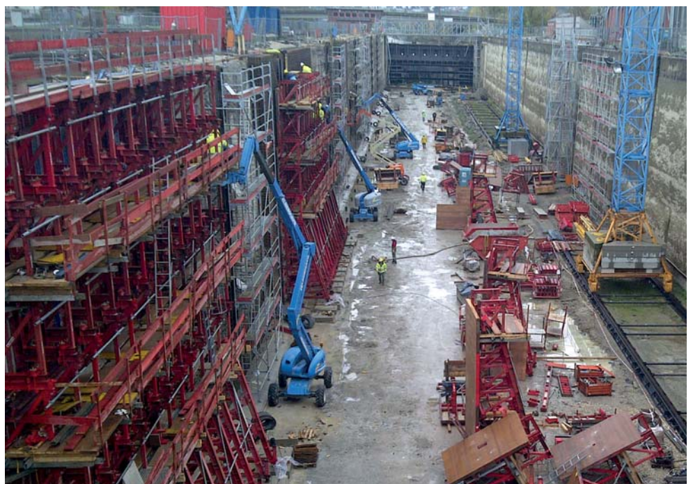
Pentru betonarea pânzelor subțiri de căptușire de la cele două bazine ale ecluzei trebuie să fie construiți peste 6.000 metri pătrați de cofraj.
