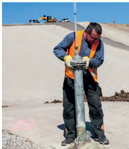
Cu ajutorul aparaturii cu coloane de apă este testată densitatea constructului.
