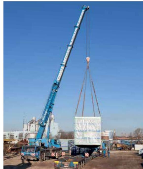
**81 der insgesamt 210 Raummodule wurden im Felbermayr-Schwerlasthafen in Linz zwischengelagert und „just in time“ auf die Baustelle transportiert.**
