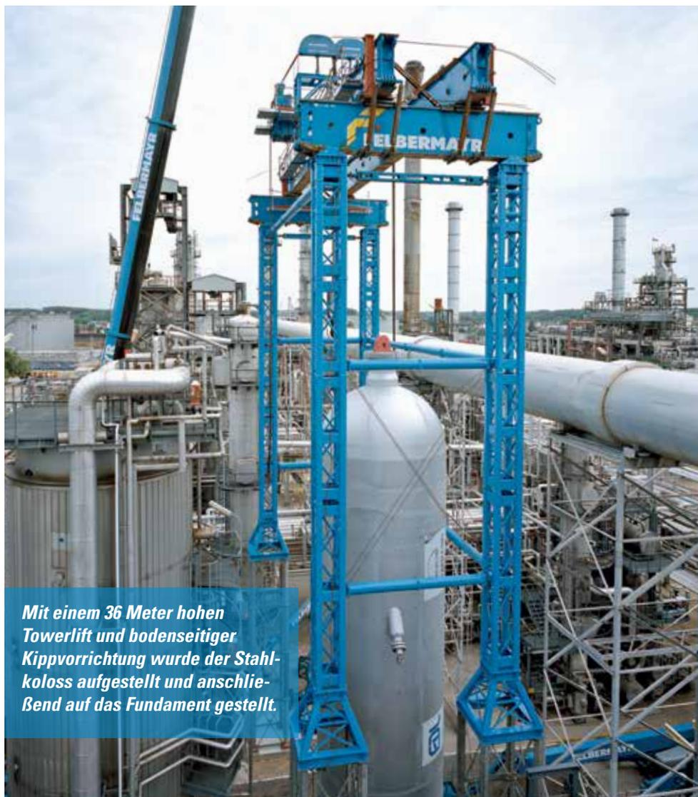
**Mit einem 36 Meter hohen Towerlift und bodenseitiger Kippvorrichtung wurde der Stahlkoloss aufgestellt und anschließend auf das Fundament gestellt.**
