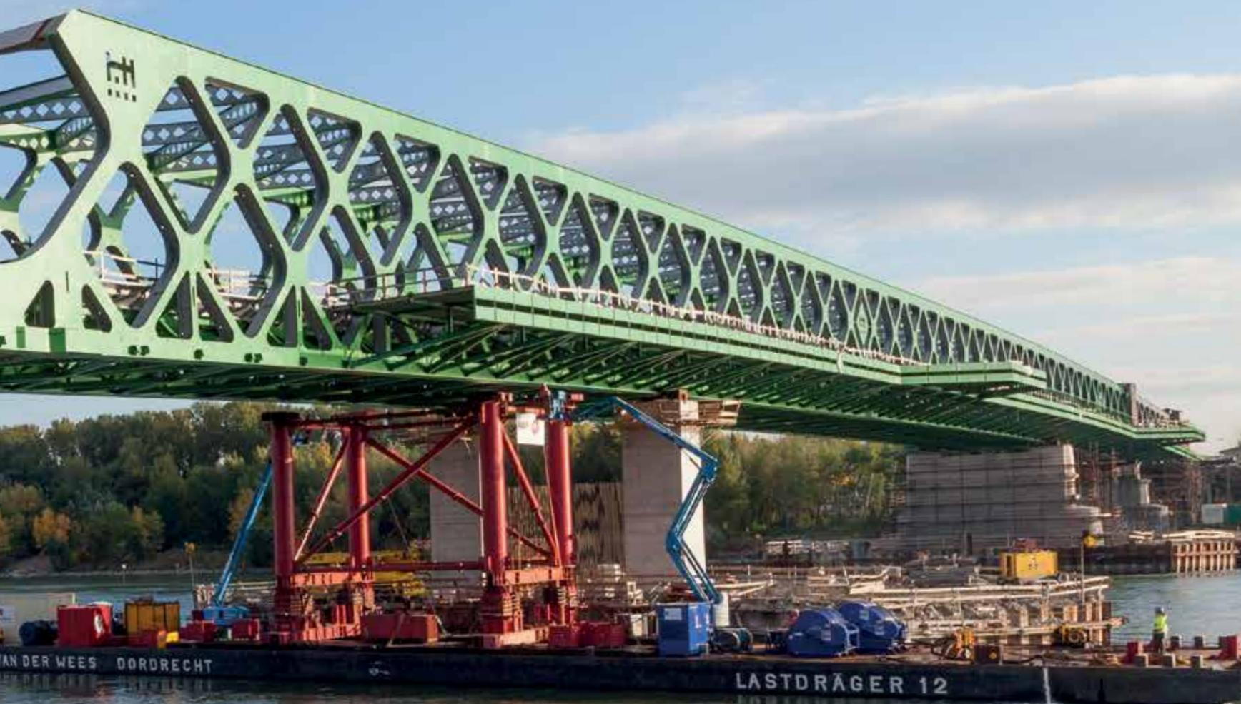
*Nach monatelanger Vorarbeit wurde im Oktober das Einschieben des 2.400 Tonnen schweren und 450 Meter langen Brückentragwerks der „Alten Brücke“ in Bratislava finalisiert. Zum Einsatz kamen dafür landseitig hydraulische Pressen für den Vorschub der Brücke und wasserseitig ein Ponton zur Lastaufnahme und zum Trimmen der Brückenhöhe.*
