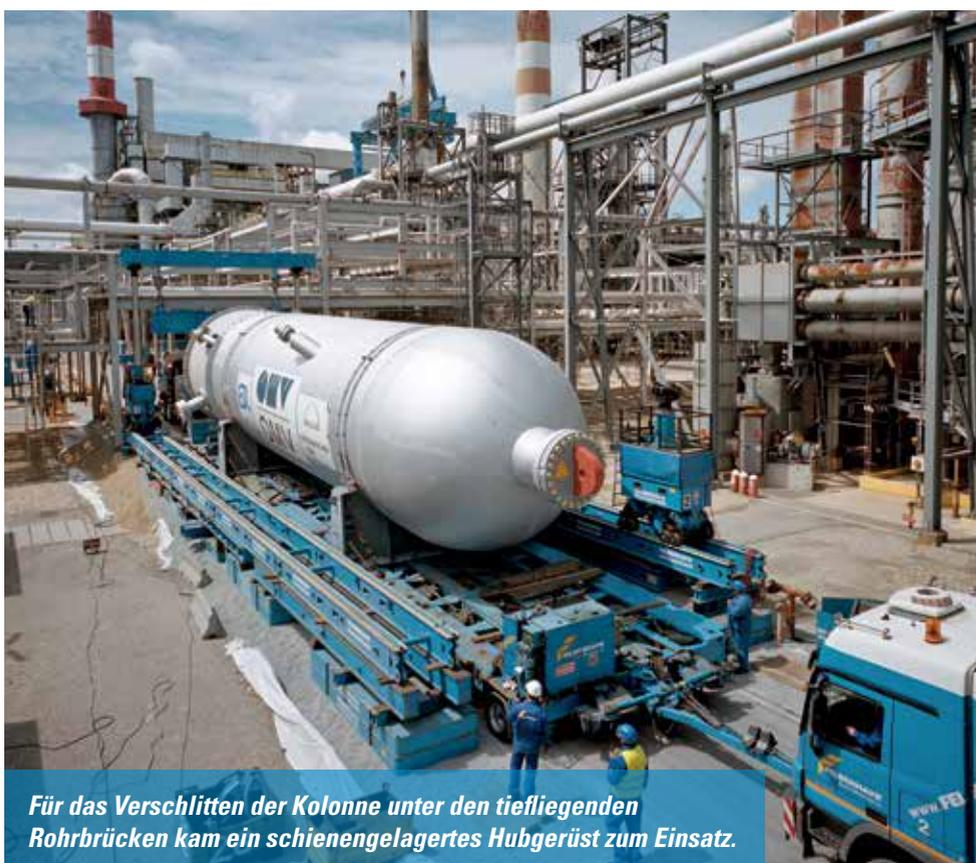
*Für das Verschleppen der Kolonne unter den tiefliegenden Rohrbrücken kam ein schienengelagertes Hubgerüst zum Einsatz.*
