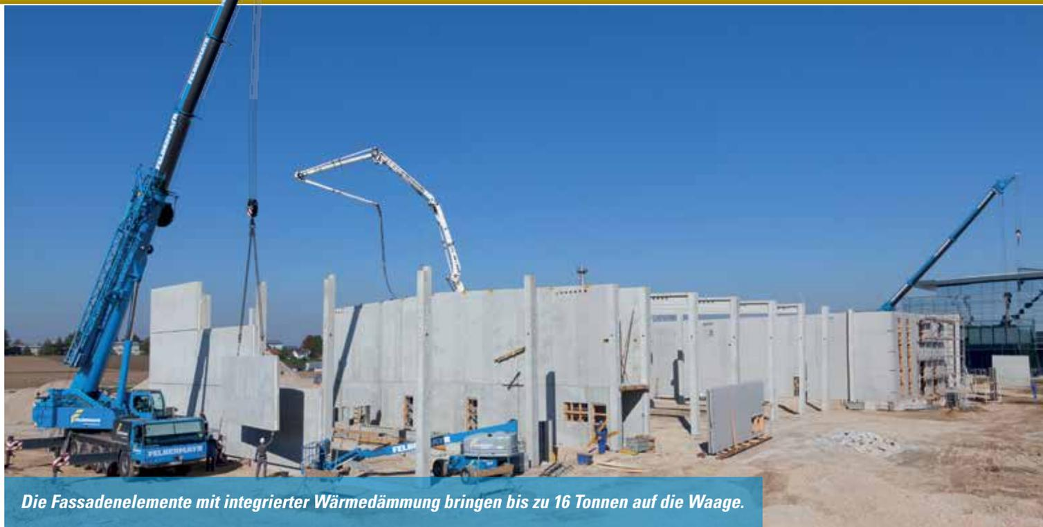
Die Fassadenelemente mit integrierter Wärmedämmung bringen bis zu 16 Tonnen auf die Waage.
