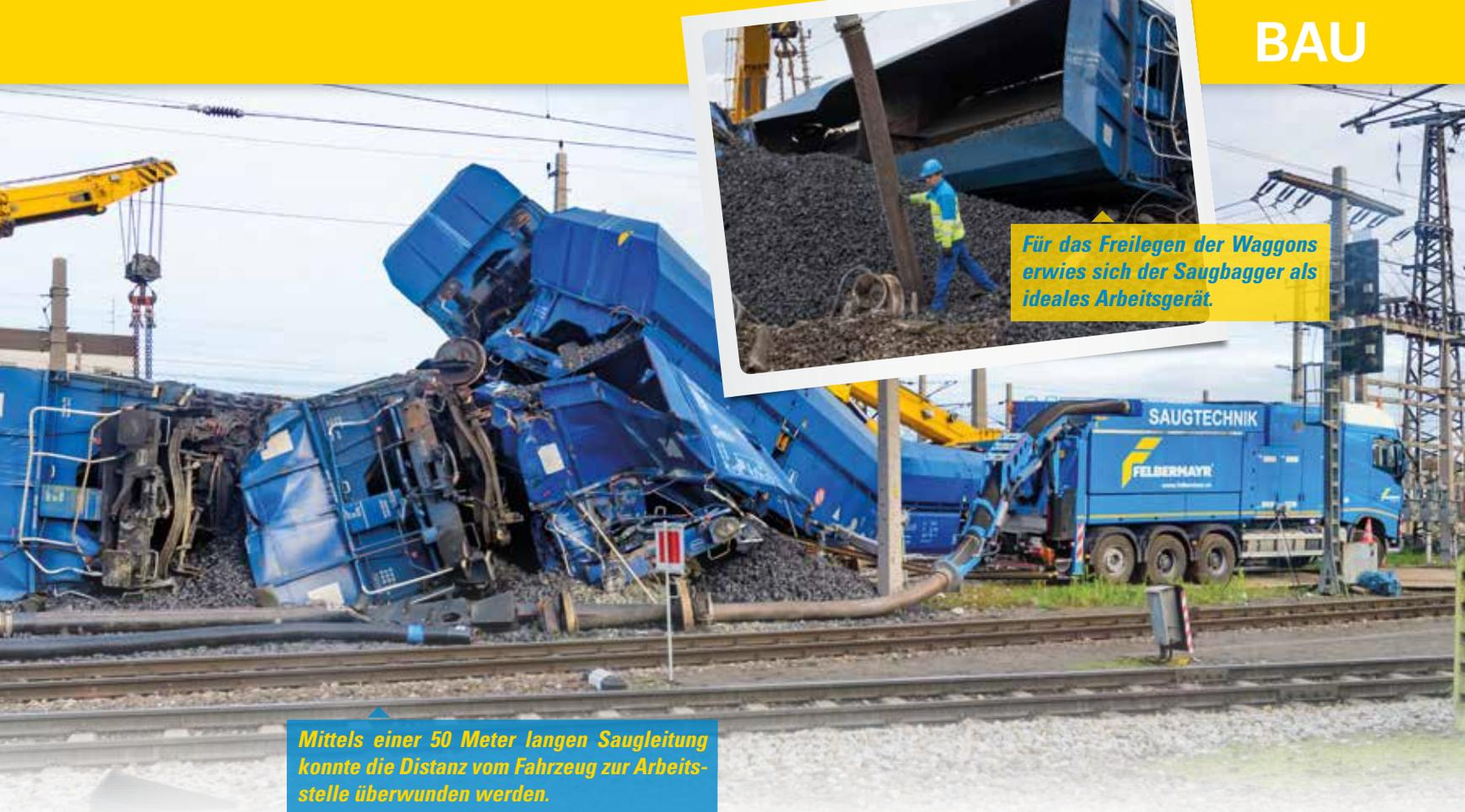
Für das Freilegen der Waggons erwies sich der Saugbagger als ideales Arbeitsgerät.
