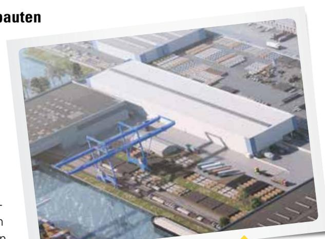
**Die neue Lagerhalle wird rund 9.000 Quadratmeter groß sein und auch über einen Laufkran mit 40 Tonnen Traglast verfügen.**
