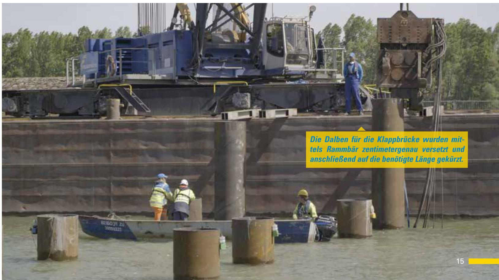
*Die Dalben für die Klappbrücke wurden mittels Rammbar zentimetergenau versetzt und anschließend auf die benötigte Länge gekürzt.*
