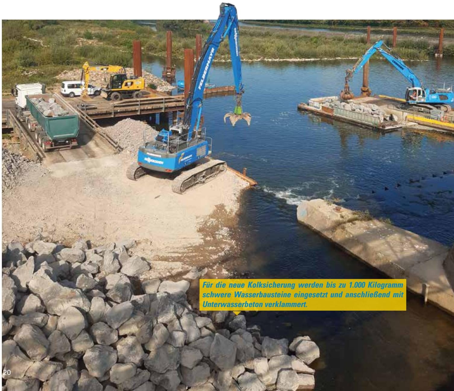
Für die neue Kolksicherung werden bis zu 1.000 Kilogramm schwere Wasserbausteine eingesetzt und anschließend mit Unterwasserbeton verklammert.
