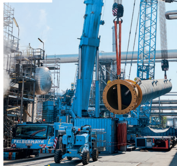
Für das Aufrichten der Behälter kam ein 500-Tonner als Nachführkran zum Einsatz.
