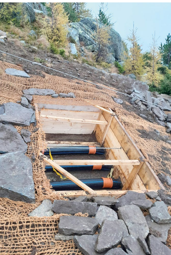
An insgesamt 14 Betonfixpunkten wird das Kabel nach dem Kabelzug in der Steilstrecke fixiert.
