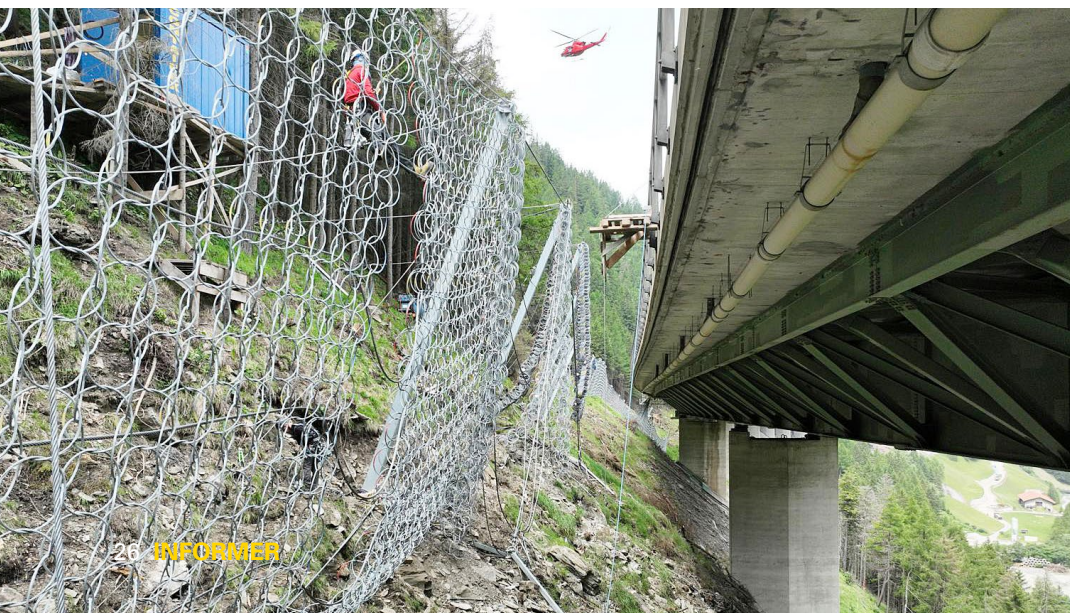
Mit einer Stützhöhe von bis zu acht Metern können die Steinschlagschutzzaune bis zu 5.000 Kilojoule Fallgewicht entgegenwirken.
