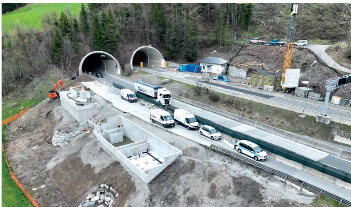
Pe lângă lucrările subterane, au fost efectuate lucrări de pământ, lucrări de construcții subterane speciale și de construcții supratere. De exemplu, construcția a opt noi clădiri operaționale.
