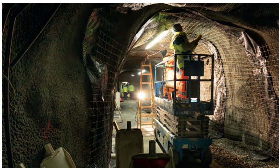
Galeriile de fugă au fost întărite și căptușite cu beton torcretat.
