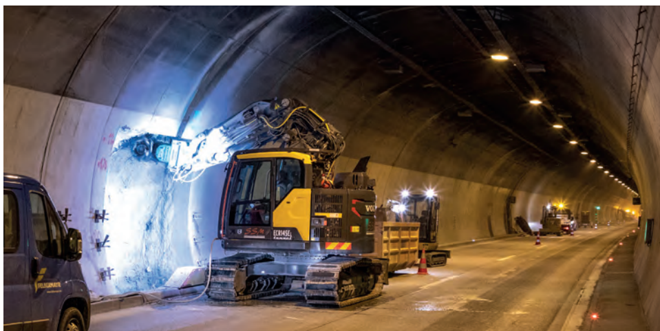
Ca urmare a noii legislații, în pereții tunelului existent au fost frezate nișe pentru apeluri de urgență și pentru stingerea incendiilor.
