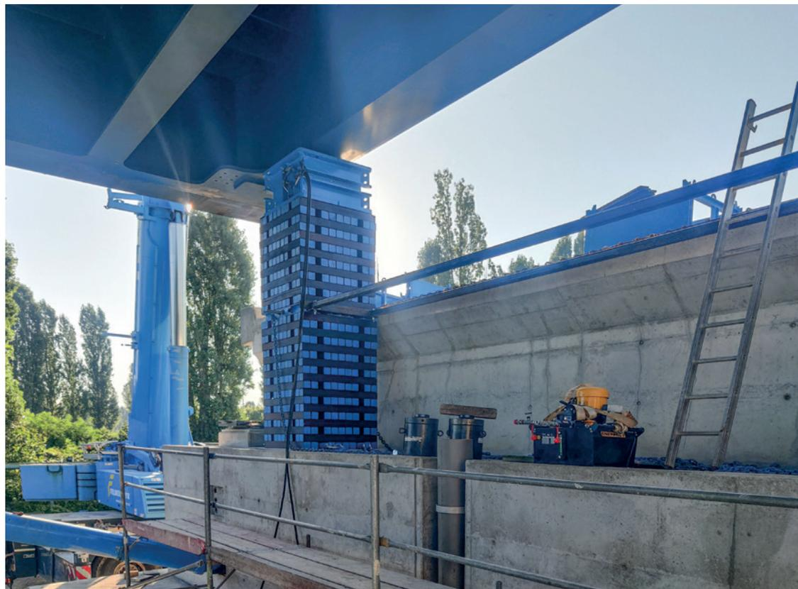
**Insgesamt vier Kletterpressen ermöglichten den Rückbau der Konstruktionen und ein „Abstapeln“ auf die künftige Endposition.**
