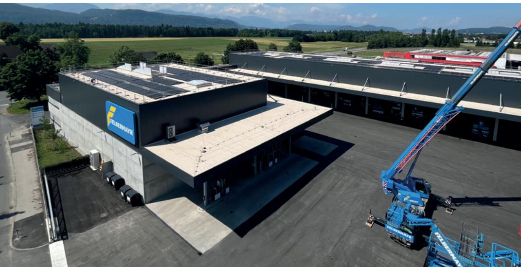
*Mit dem Neubau einer 1.800 Quadratmeter großen Kalthalle wurde zusätzlich ein sicherer Unterstand für Maschinen und Gerätschaften geschaffen. Zusätzlich aufgewertet wird der Standort durch eine großzügige Photovoltaikanlage. Mit dieser können bis zu 70 Prozent des Stromverbrauches im Monat abgedeckt werden.*
