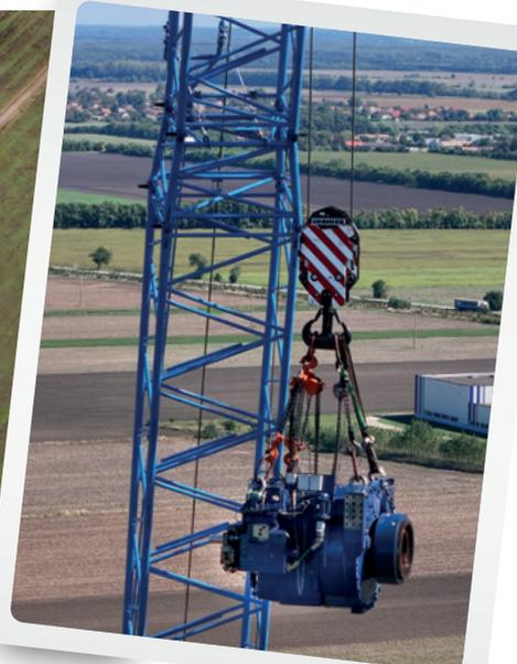
Für eine Windkraftanlage im ungarischen Janossomorja kam Ende vergangenen Jahres ein Mobilkran mit einer maximalen Traglast von 650 Tonnen zum Einsatz. Damit gelang es, ein rund 19 Tonnen schweres Getriebe im 115 Meter hoch gelegenen Maschinenhaus zu tauschen.
