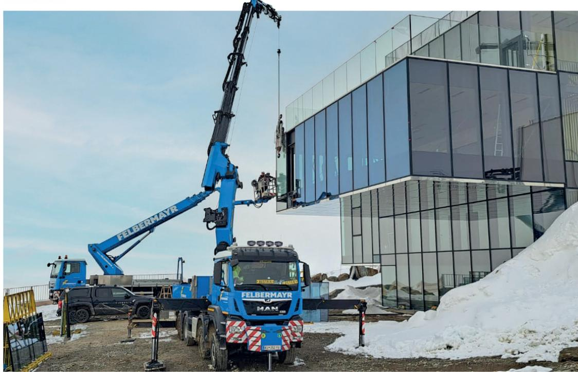
ten Straße geringeren Bruchgefahr mit dem Helikopter angeliefert. Notwendig wurde der Glastausch bei dem 2012 errichteten Gourmetrestaurants aufgrund des starken Wärmeeintrags. Die neuen
