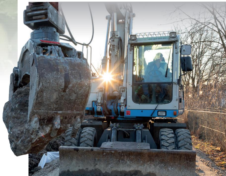
**Ein Bagger positionierte die Wasserbausteine in transportable Happen zur Aufnahme für den Kran.**
