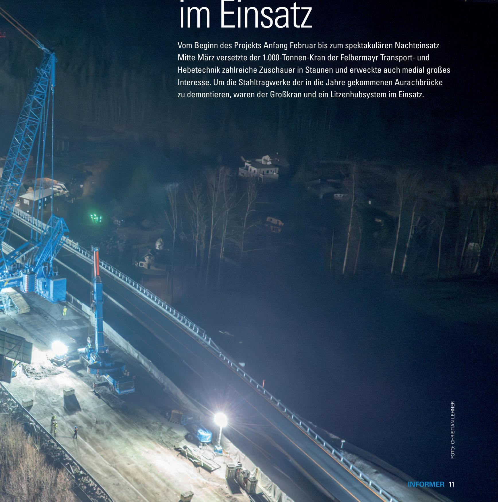
**Für das Ausheben der mittleren Brückentragwerke wurde der Raupenkran auch im Tal positioniert. Die Länge des Hauptauslegers betrug dabei 114 Meter.**
