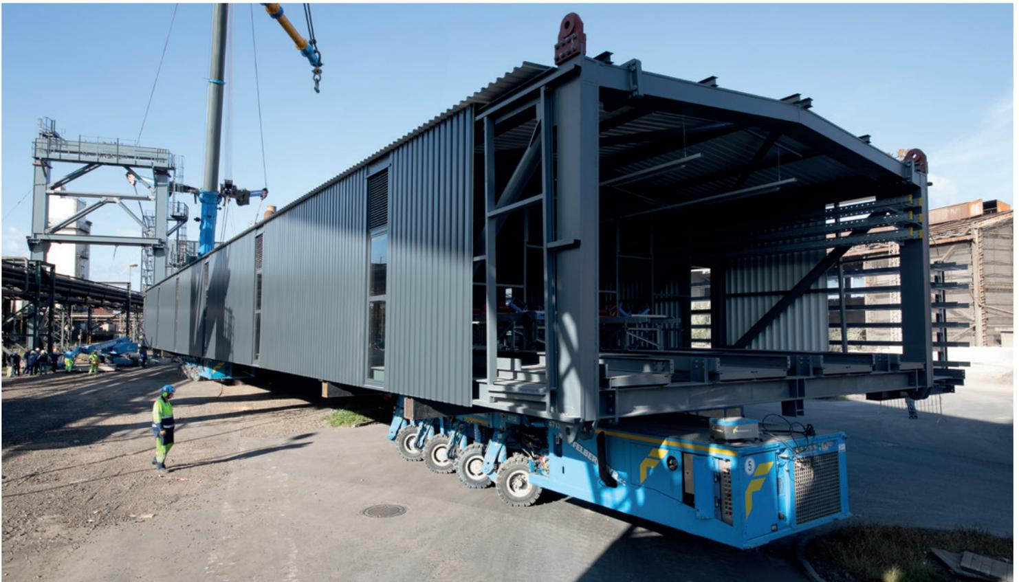
Mit dem SPMT wurden die vormontierten Segmente der Förderbandbrücke unter den Kränen in Hubposition gebracht. Bei Längen von bis zu 62 Metern brachten die insgesamt sieben Elemente maximal 180 Tonnen Einzelgewicht auf die Waage.
