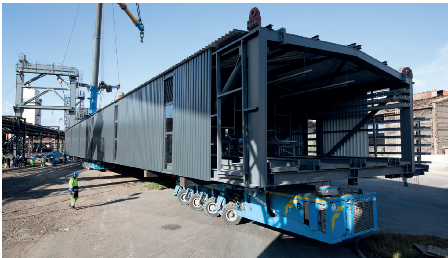
SPMT a deplasat segmentele preasamblate ale podului benzii transportoare sub macarale în poziția de ridicare. La lungimi de aproximativ 62 de metri, cele șapte elemente au cântărit în total maximum 180 de tone.
