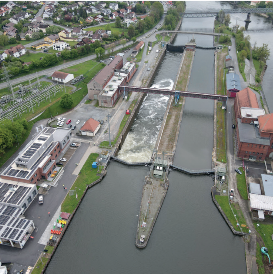
PHOTOS: ROBL SPEZIALTIEFBAU, DANIEL COBAN, HABAU/NORBERT ENDERS
